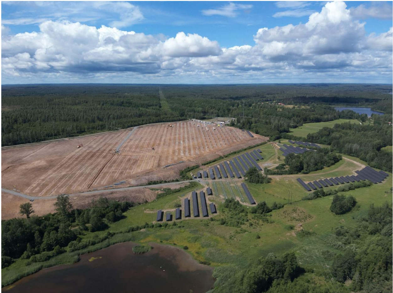
Figur 16: Mörghult solkraftverk (14,1 MWp) er ett av Solgrid sine prosjekter i Sverige.
