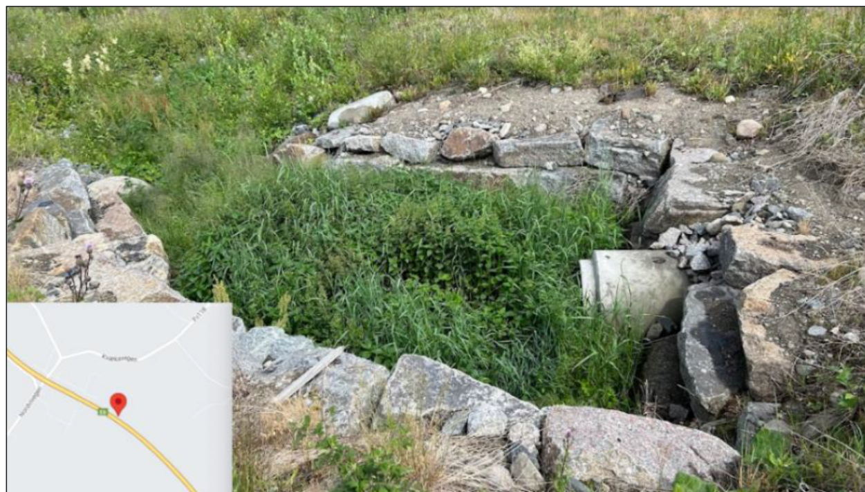
Figur 18: Bilde av utløpet ved kulvert nr. 1 (se nummerering i Figur 17).
