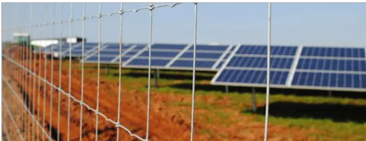
Figur 12: Bildeeksempel av et typisk gjerde rundt et solkraftverk (Solfarm, 2023).
