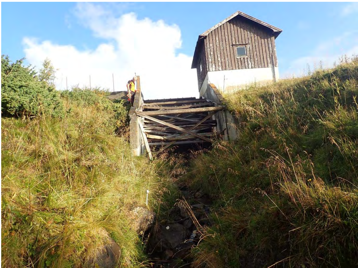
Figur 10. Forsterket overløp ventilhus.
