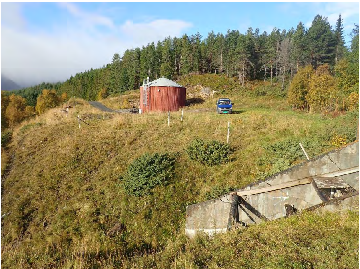
Figur 16. Nedstrøms sett mot vanntårn.
