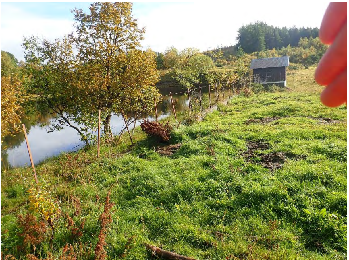
Figur 2. Dam Bjarkøy og magasin.
