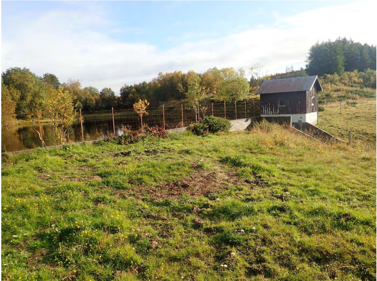
Figur 1. Ventilhus Dam Bjarkøy.
