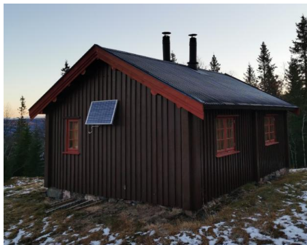
Figur 5-13: Modernisert bygning ved Haugestaul.
