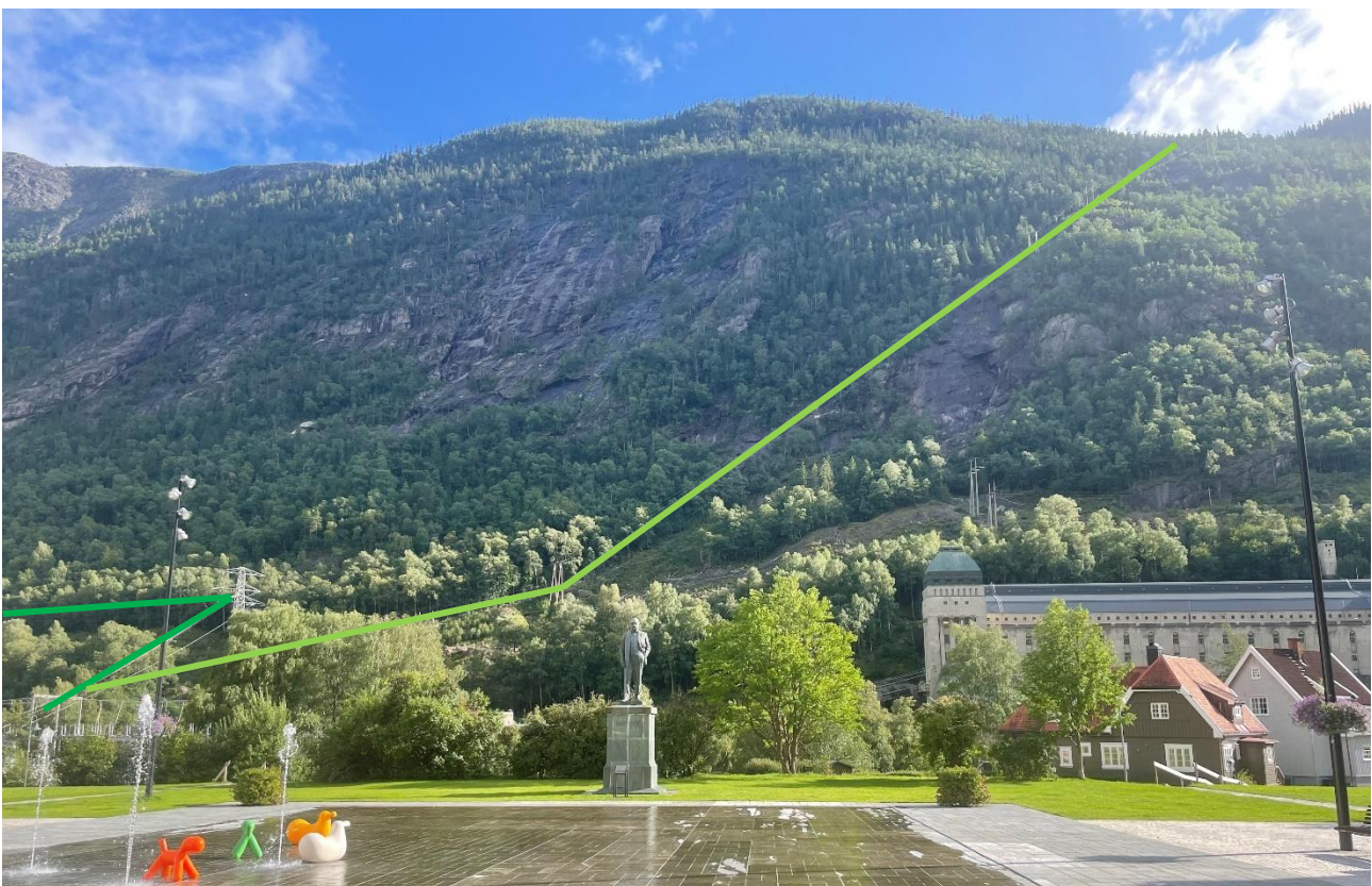
Figur 2-20. Bildet viser traseen til ledningene som Lede søker om å rive (grønn Såheim-Mår, lysegrønn Såheim-Årlifoss). Bildet er tatt fra torget i Rjukan.
