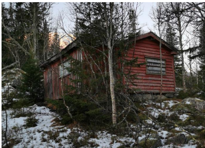
Figur 5-12: Bygning i nærheten av Haugestaul. Bygningen er i dårlig forfatning. Bygningen er lokalisert like nord for Haugestaul.
