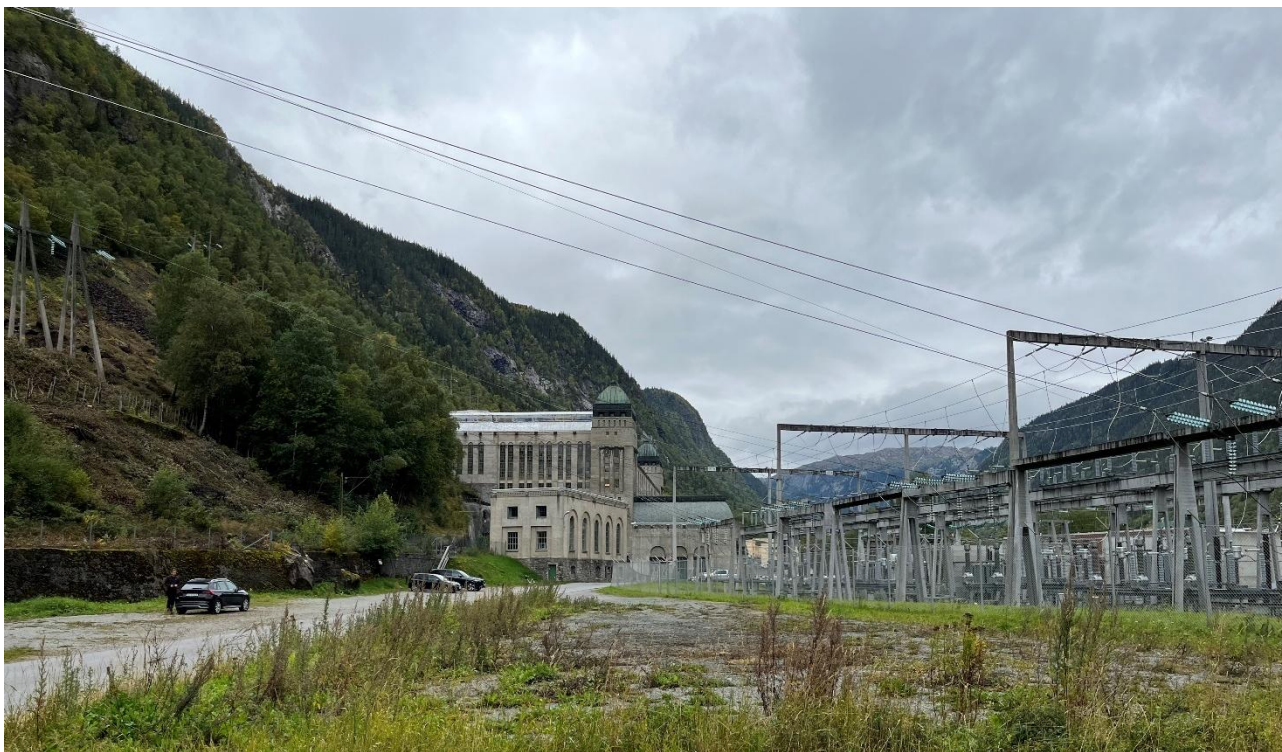
Figur 2-4. Såheim utendørsanlegg til høyre i bildet og Såheim kraftverk i bakgrunnen. Det vil etableres to master på venstre side av veien i bildet. Bildet er tatt i retning vest.
