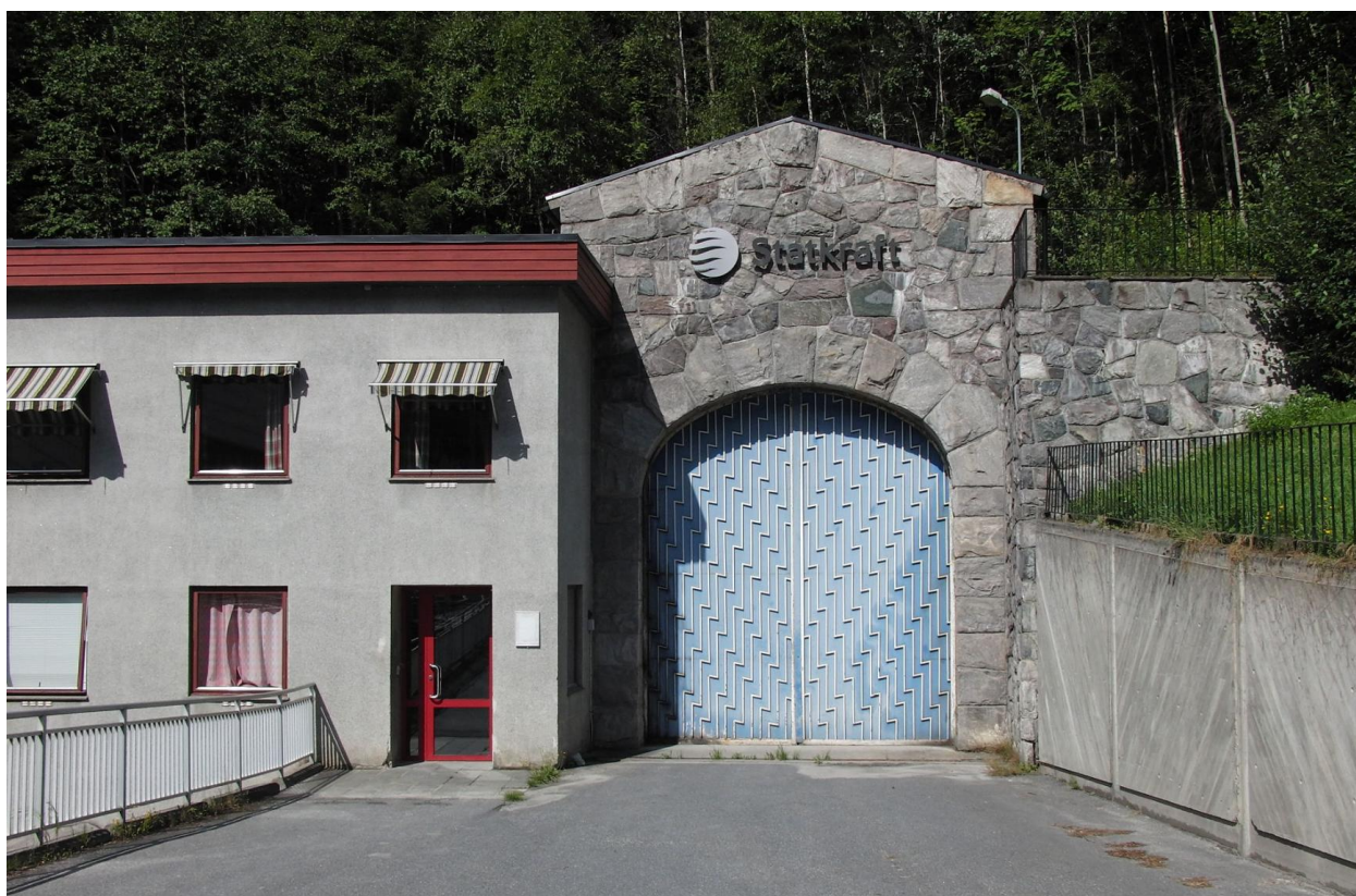
Figur 5-11: Portalbygning (id 282522). Foto: Statkraft.
