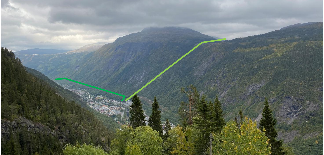
Figur 2-19. Grønn linje viser traseen til eksisterende 132 kV ledning Såheim-Mår og lysgrønn linje viser traseen til eksisterende 132 kV ledning Såheim-Årlifoss. Bildet er tatt fra Krossobanen, nordvest for Rjukan sentrum.
