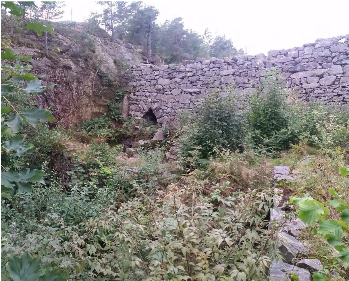
Hoveddammen før nedleggelsen fotografert fra nedstrøms side.
