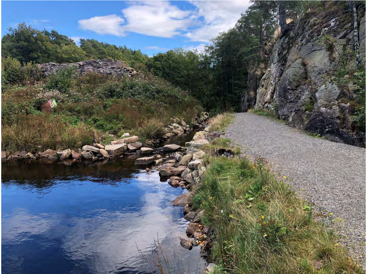
Situasjonen etter åpning sett oppstrøms fra med ny utløpskanal og turvei.
