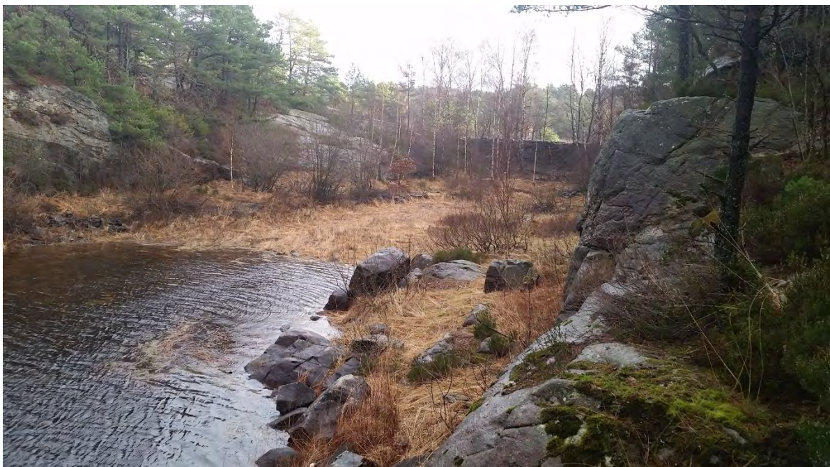
Sidedammen fotografert oppstrøms fra.
