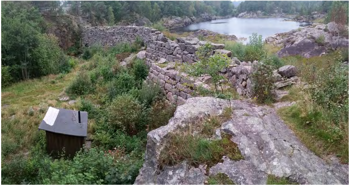
Hoveddammen før nedleggelsen fotografert nedstrøms fra nordsiden.
