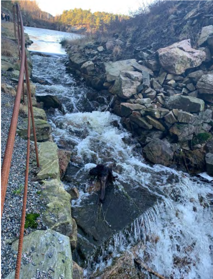
Ny utløpskanal og turvei sett nedstrøms fra.
