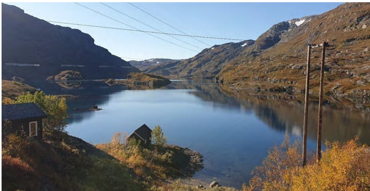
Figur 1-2 Klevavatn ved lukehus. Foto: NVE 14.9.2021.
