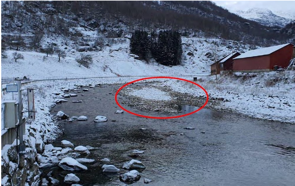
Figur 4-5 Eksempel på potensielt sårbart areal (grusør) ved Kalvebrekka, like oppstrøms bru bed Flåm kirke. Kilde: Multiconsult, 2021.
