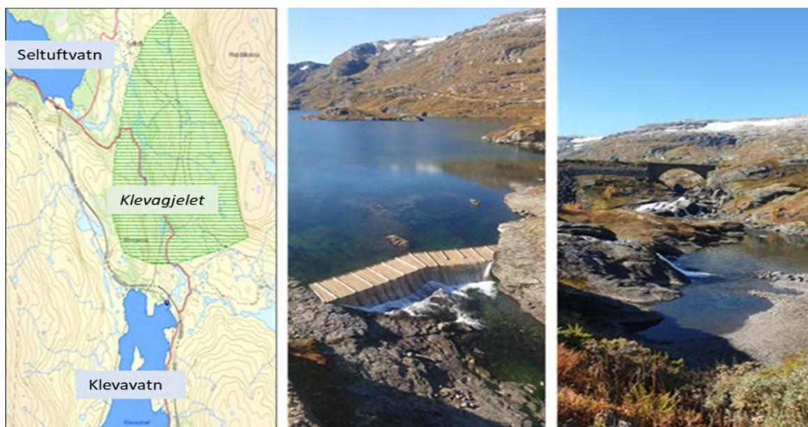
Figur 4-1 Kart som viser Klevagjelet (skravert område). Kilde: Naturbase. Bildene til høyre viser hhv. Klevavatn med overløp og Kleven bru med utløp fra Klevavatn. Foto: NVE 14.9.2021.
