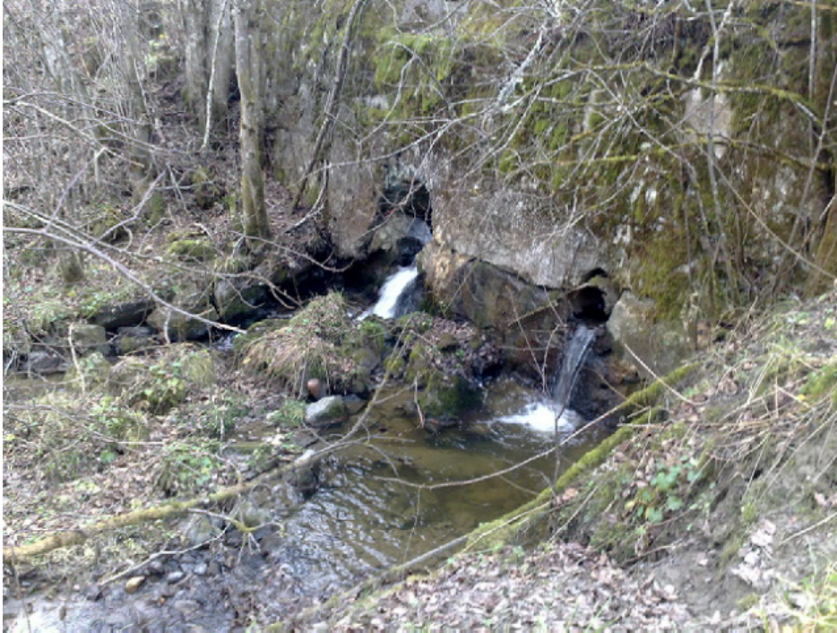
Bilde 5. Erosjonssikring avsluttes mot gammel kraftverksdam.
