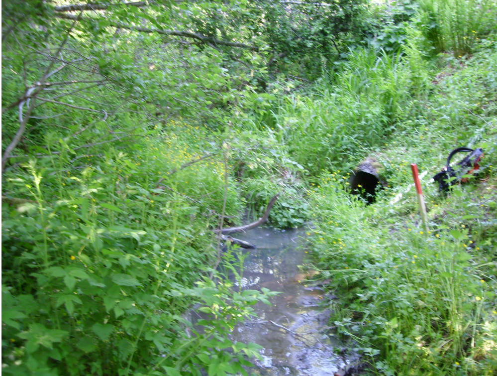
Bilde 3: Sidebekk kommer inn i Rofstadbekken via rør under veien. Denne sidebekken skal sikres.
