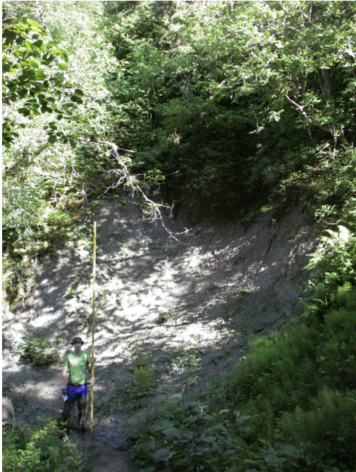
Bilde 7: Utglidning ved 980 meter Stensås – Storrønningen bekken
