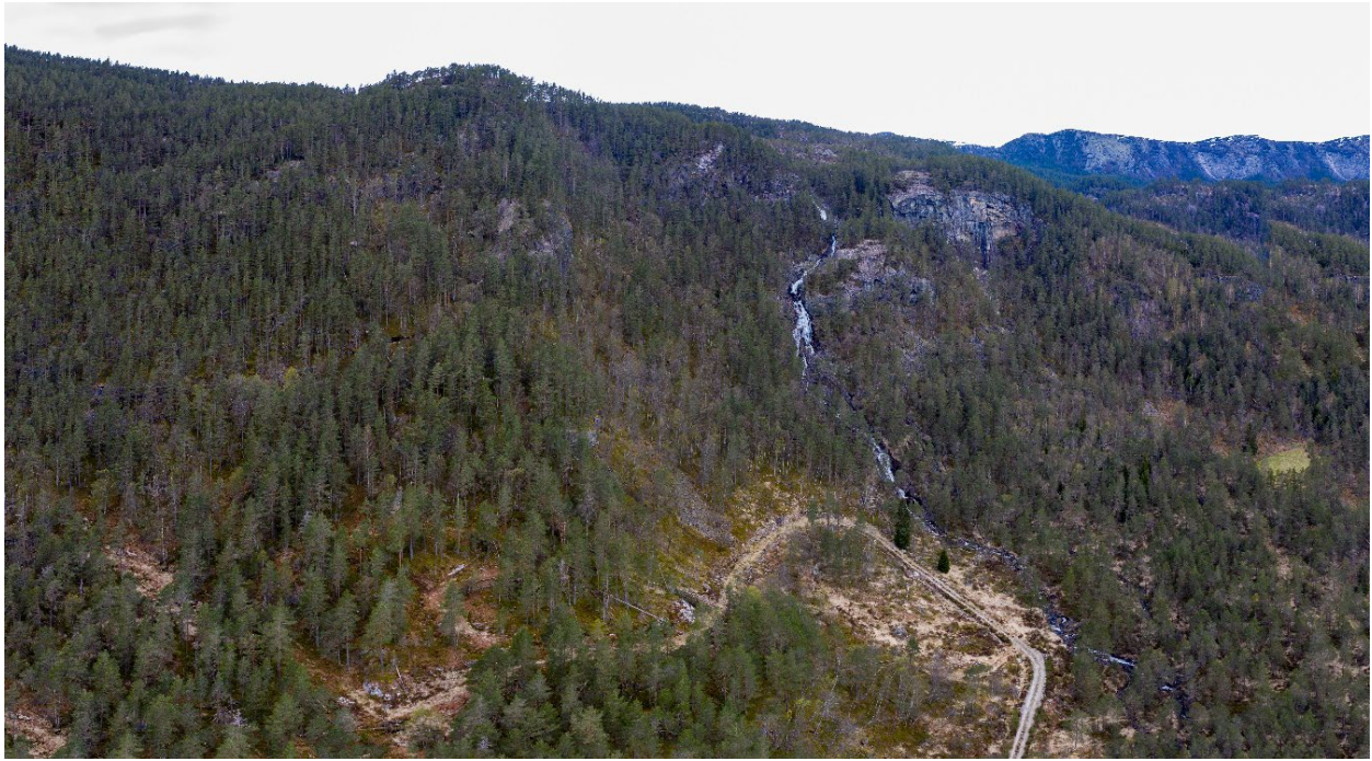
Fig.3: Haugåna. Hovedfallet ned dalsiden mot kraftstasjonsområdet (Foto: Simen Haugom – dronfoto 2020).
