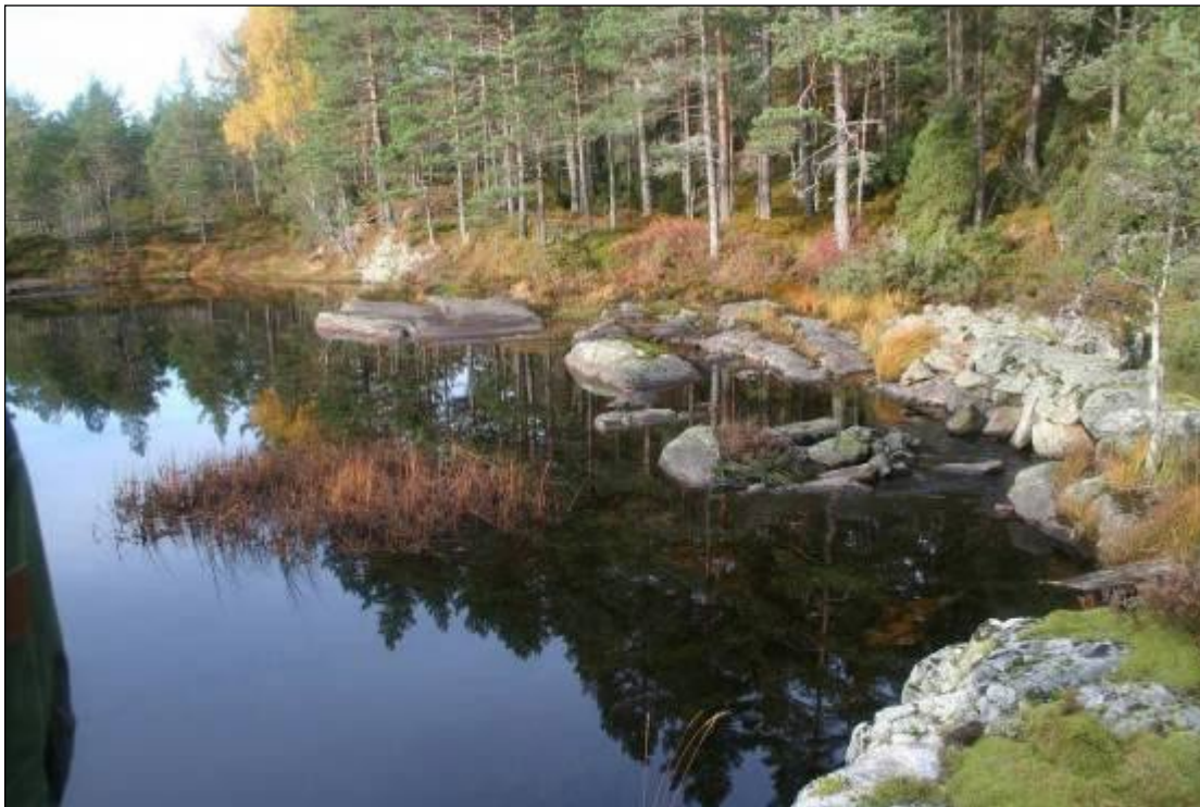
Fig.10: Nordre utløp. Gammel reguleringsdam i høyre billedkant. Ny dam bygges i forkant
