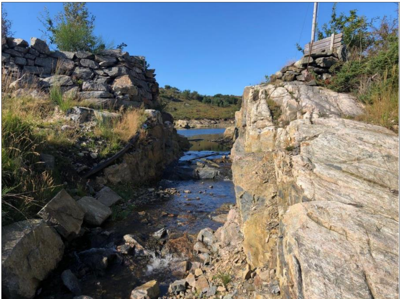
Figur 1-10. Ny kanal og overløpsterskel gjennom sidedam etablert i 2017. Kanalen skal fylles igjen med stein og løsmasser fra dam, samt lokale masser.
