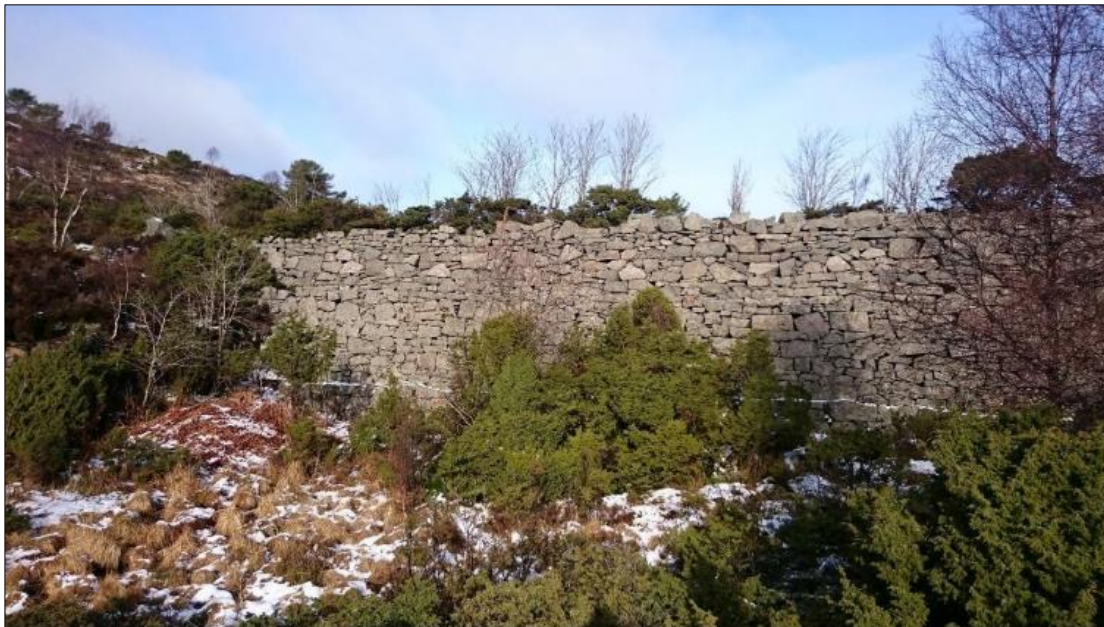
Figur 1-7. Hoveddam Storavatn, nedstrøms side (Foto: Norconsult)
