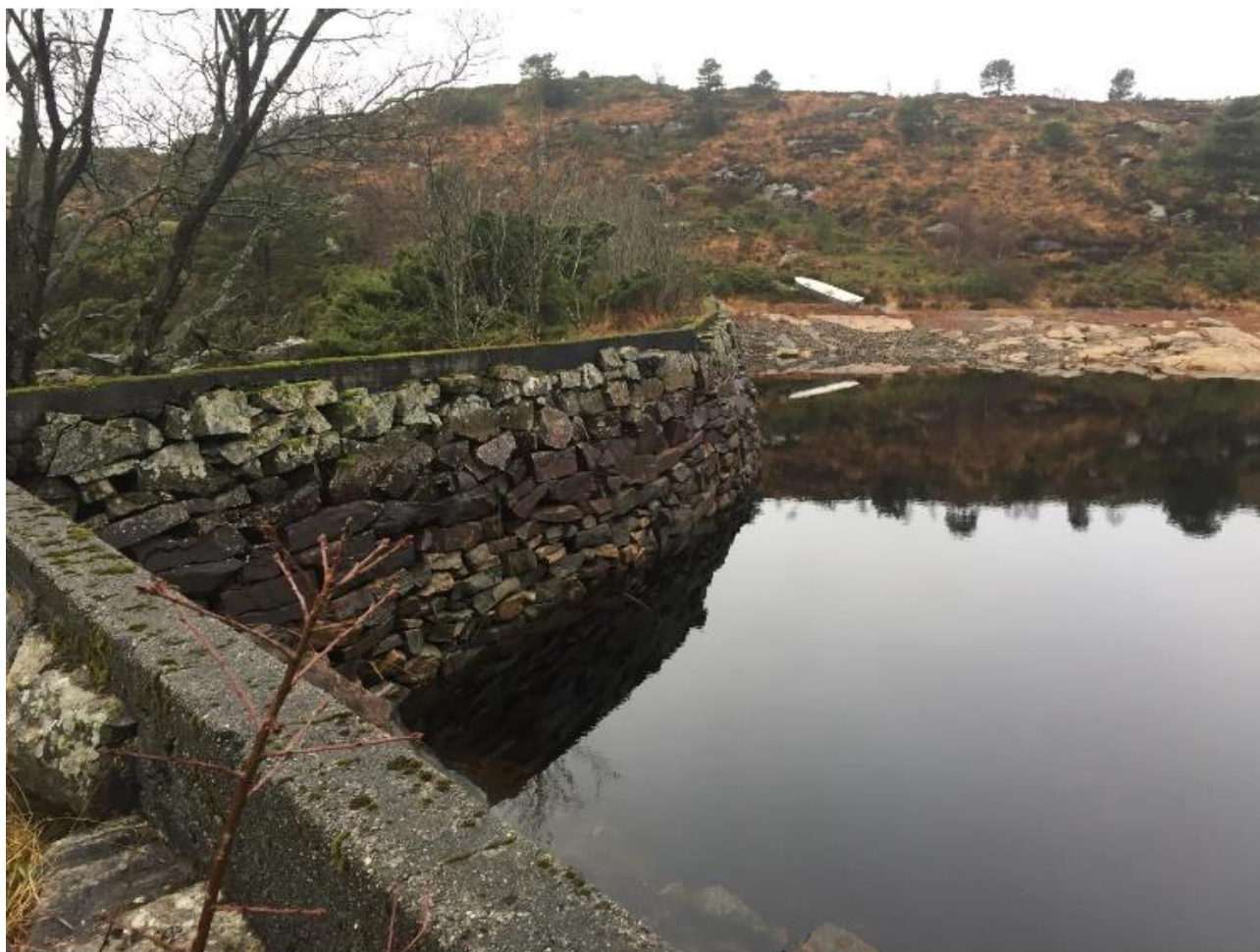
Figur 3-2. Hoveddam og topp sidedam sett fra oppstrøms side mot sørvest.
