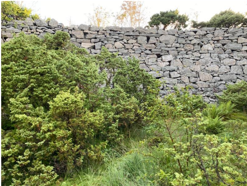
Figur 1-5. Dam Storavatn fra nedstrøms side (Foto: Sartor & Drange)
