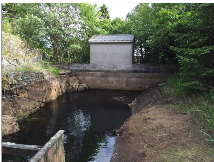
Figur 1-9. Oppstrøms side av silhus med basseng. Denne er i dag tørrlagt og silhuset skal ikke fjernes.
