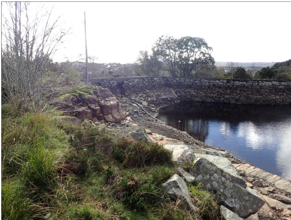
Figur 1-8. Hoveddam med sidedam til venstre, oppstrøms side. Bildet er tatt mot sørøst.
