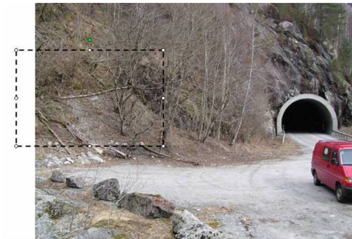
Figur 1.4 Kraftstasjonen plasseres i utravd nisje bak parkeringsplassen
