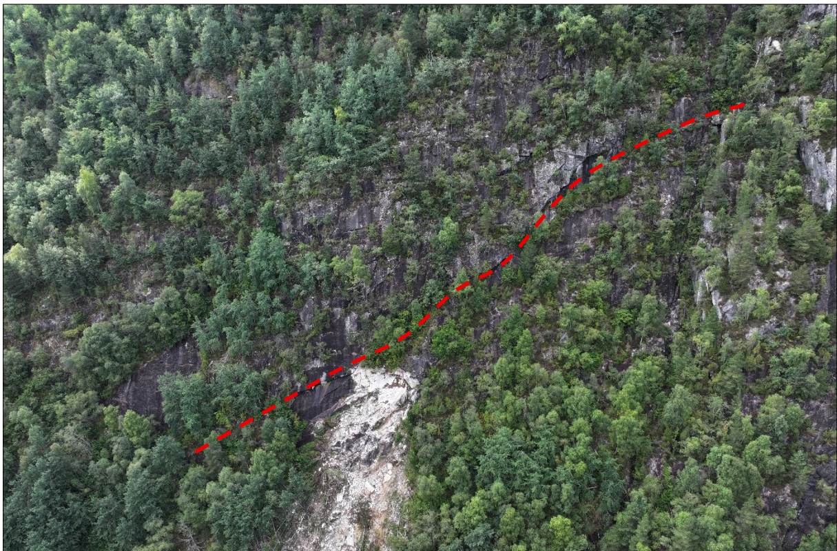
Figur 8: Bilete av midtre del av fjellsida viser skredsåret etter hendinga som skjedde i april 2025. Skredet har losna langs eit sprekkeplan i fjellsida, tolka å vere ein svakheitssone i overgangen mellom migmatitt og kvartsitt. Infopunkt 6.
