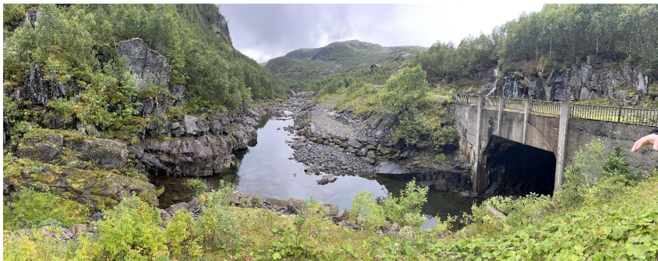
Figur 5-6 Nedstrøms Dam Valldalen
