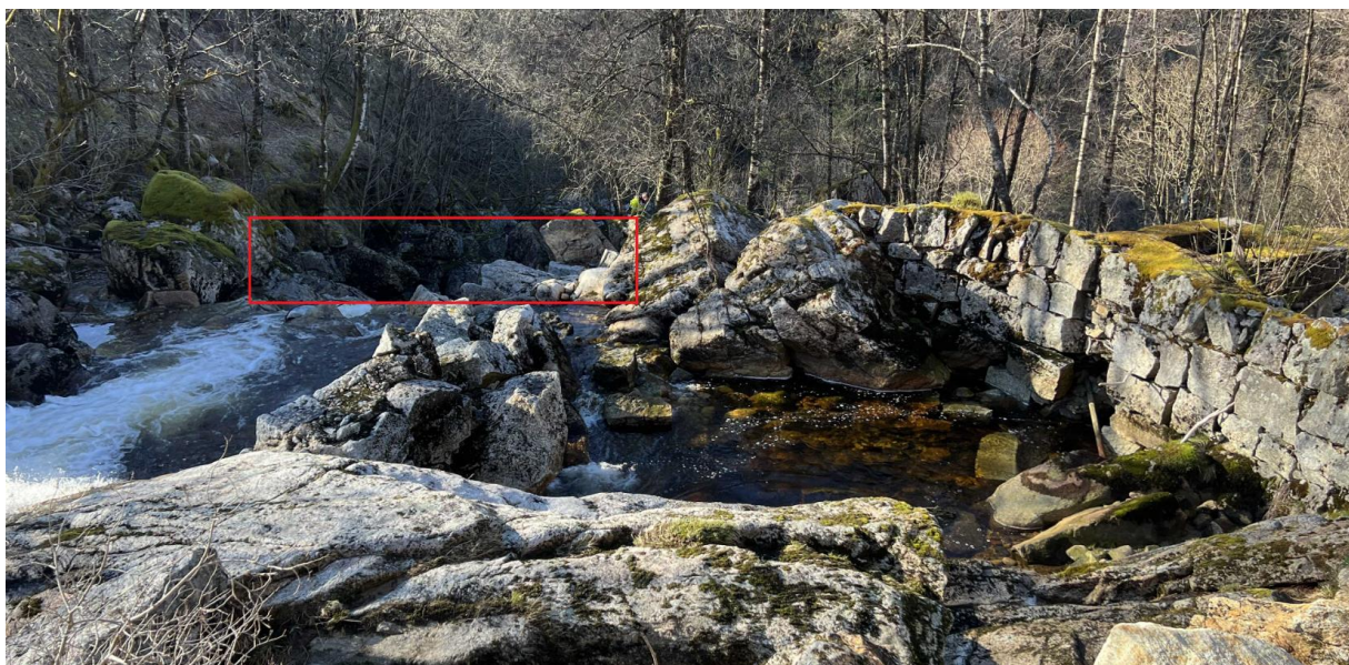
Figur 9, bjelkestengsel ved midlertidig omlegging av vannføring
