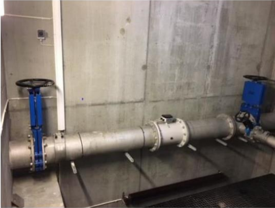
Figur 14. Bildet viser et minstevannføringsrør etablert med revisjonsventil til venstre, elektromagnetisk vannføringsmåler montert i en egen rørdel (hvit) og reguleringsventil for regulering av vannmengde til høyre i bildet. Foto: NVE
