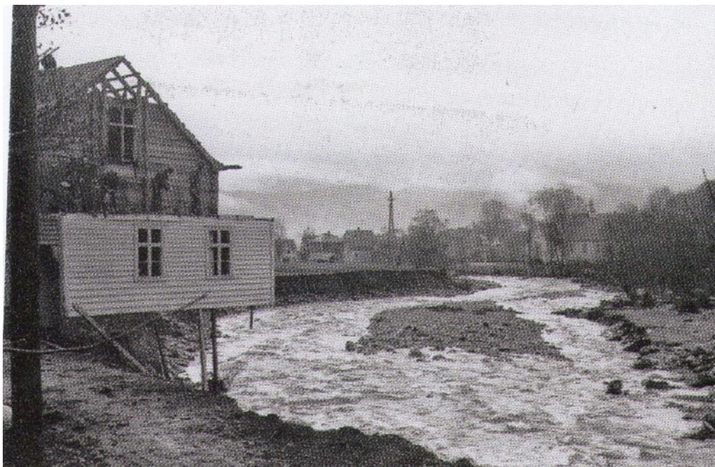
Figur 4. Utsikt nedover Øysteseelva etter storflommen i 1938. Bildet tatt fra oppstrøms bedehuset. Elven har erodert mye mot øst og lagt seg en sandbar midt i elveløpet. Ungdomshuset og idrettsplassen var erosjonssikret og fikk ikke skader (synlig i bildet). Foto: T. Lofthus.
