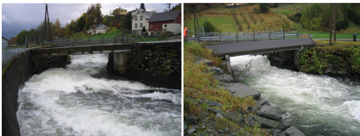
Figur 4-6. Sjusetvegen bru. Til venstre: sett fra oppstrøms. Til høyre: sett fra nedstrøms. Foto: Novatek, 2007 [11].
