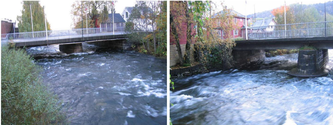
Figur 4-12. Hardangerfjordvegen bru. Til venstre: Sett fra oppstrøms. Til høyre: Sett fra nedstrøms. Foto: Novatek, 2007 [11].
