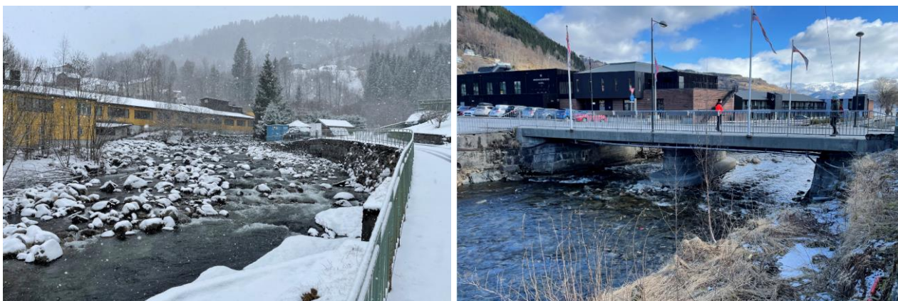
Figur 6-1. Til venstre: Utsikt oppstrøms Sjusetevegen bru. Til høyre: Forhold oppstrøms Hardangerfjordvegen bru. Foto: Norconsult, 27. og 28. mars, 2023.
