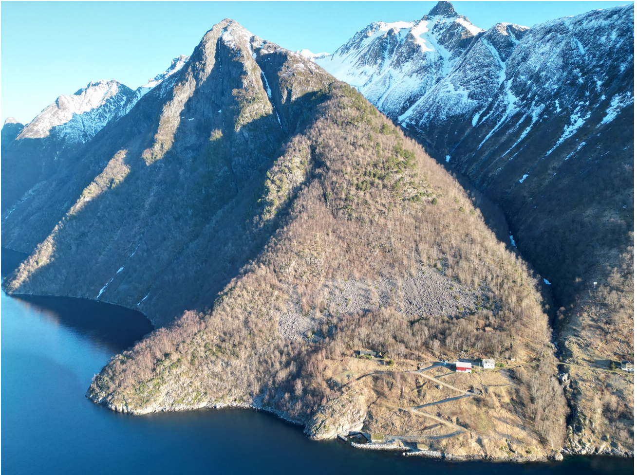
Bilde 1. Oversiktsbilde over påvirkning- og kartleggingsområdet, sett fra sørvest.
