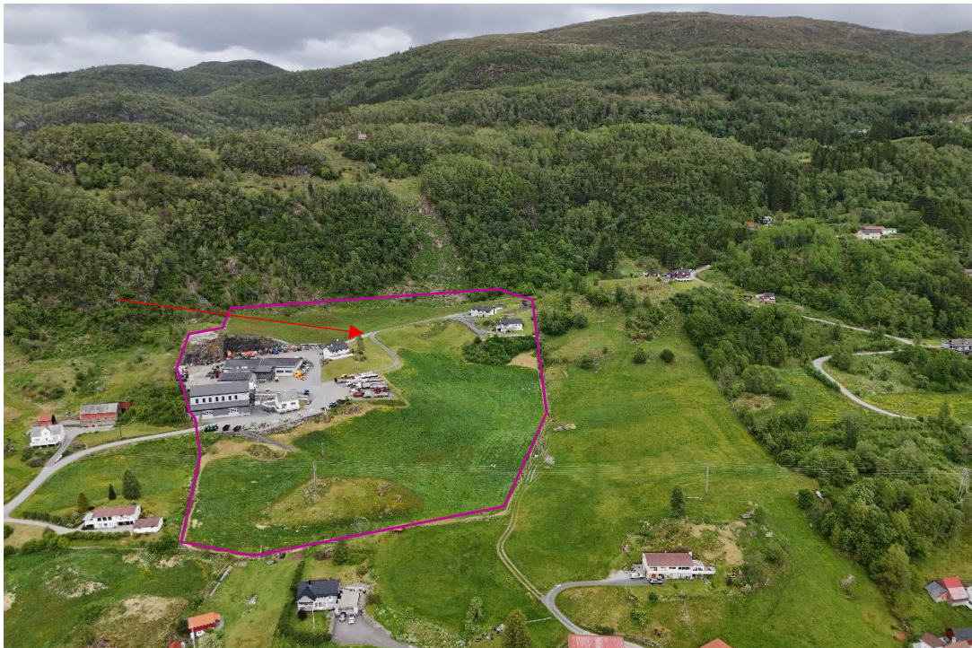
Figur 1: Oversiktsbilde over kartleggingsområdet (lilla markering) og påvirkningsområdet i dalsida bak. Bildet er tatt mot nord. Rød pil viser inntak bekkelukking med erosjonssikring.
