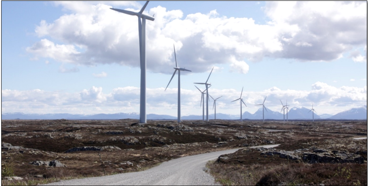
Figur 2-4. Smøla vindkraftverk med internveger og vindturbiner. Vegene i et vindkraftverk har normalt en bredde på ca. 5-6 m og grusdekke.
