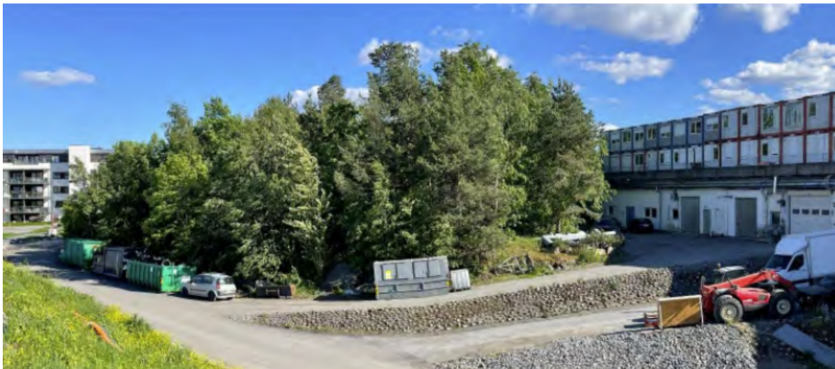
Figur 6: Kollen sett fra nordøst. Transformatorstasjonen skal bygges bak kollen i bildet, mellom kollen og boligblokkene som en ser deler av til venstre i bildet. Kilde: NVEs Bakgrunn for vedtak av 18. april 2023.
