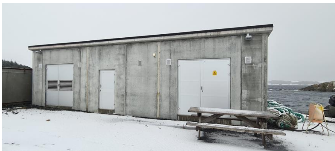
Figur 2 - Eksisterende nettstasjon på Kjebogen industriområde
