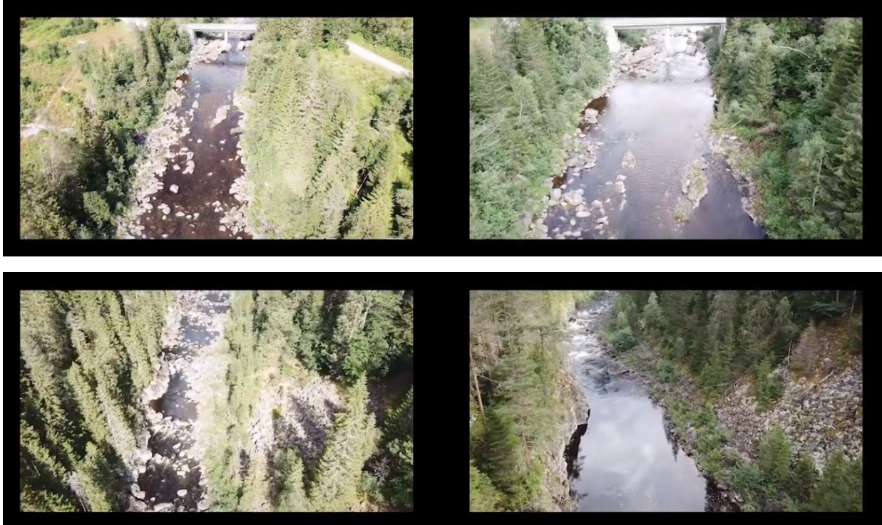
Figur 7.1.4. Tokkeåi ved Omdal bru (øverst) og oppstrøms Omdal bru (nederst) med vannslipp fra Vinjevatn på hhv. 0,65 \text{ m}^3/\text{s} og 2 \text{ m}^3/\text{s} . Vannføringen ved Omdal bru er her ca. 1,5 \text{ m}^3/\text{s} og 2,8 \text{ m}^3/\text{s} . (Kilde: Youtube)
