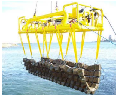
Figur 13 Utlegging av betongmadrasser
