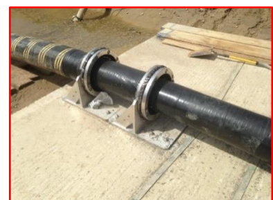
Figur 19 – Forankring av søkablet på land
