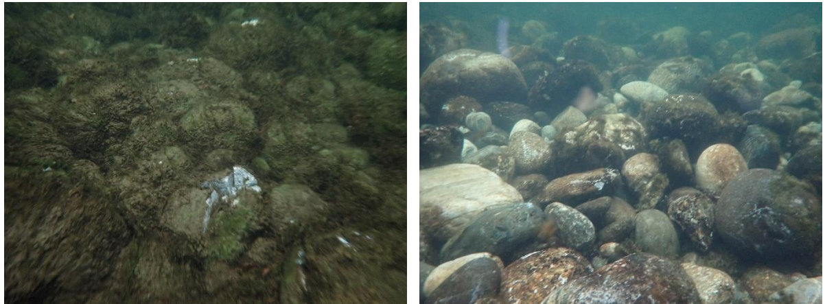
Figur 6. Ikke-rippet (venstre) og rippet (høyre) elvebunn i tiltaksområde 1 mellom Stråpa og Notahølen 2021.
