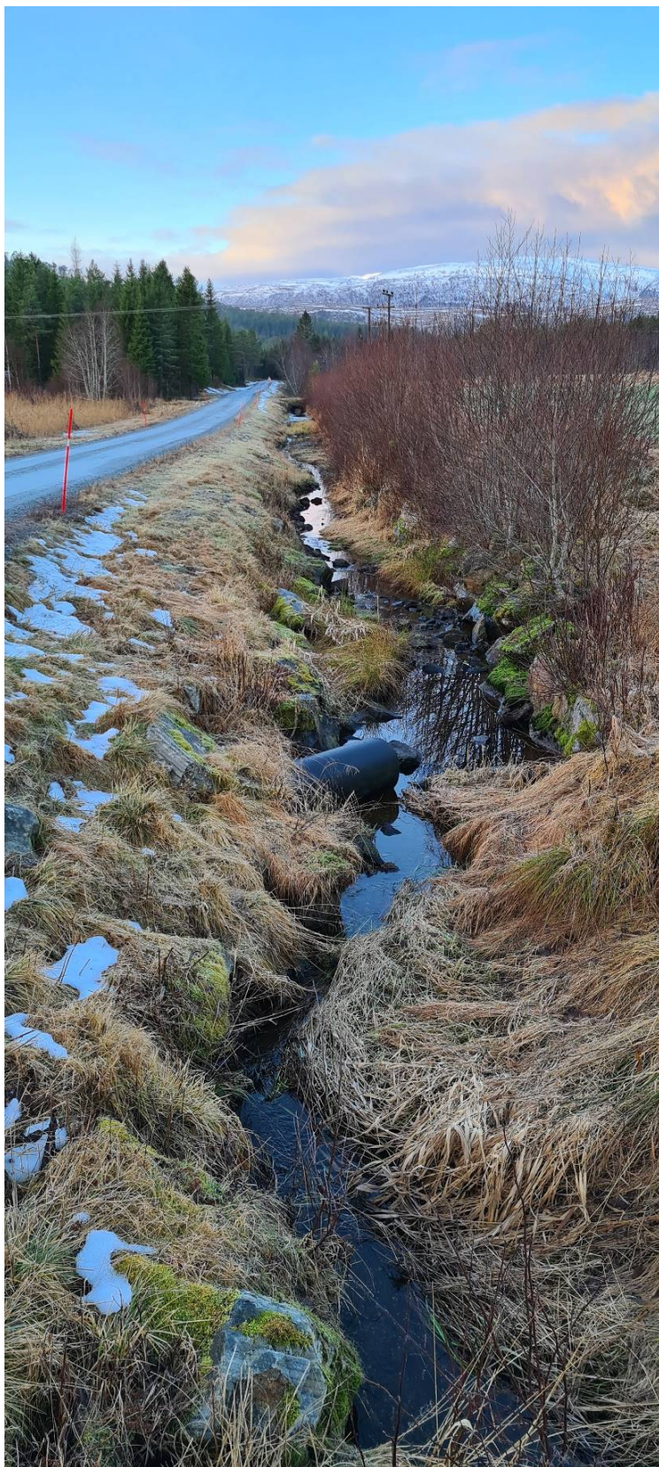
Figur 4 Utløp fra overføring i rør fra Fjerdingsgen til bekkefar på østsiden av Utnesveien.
