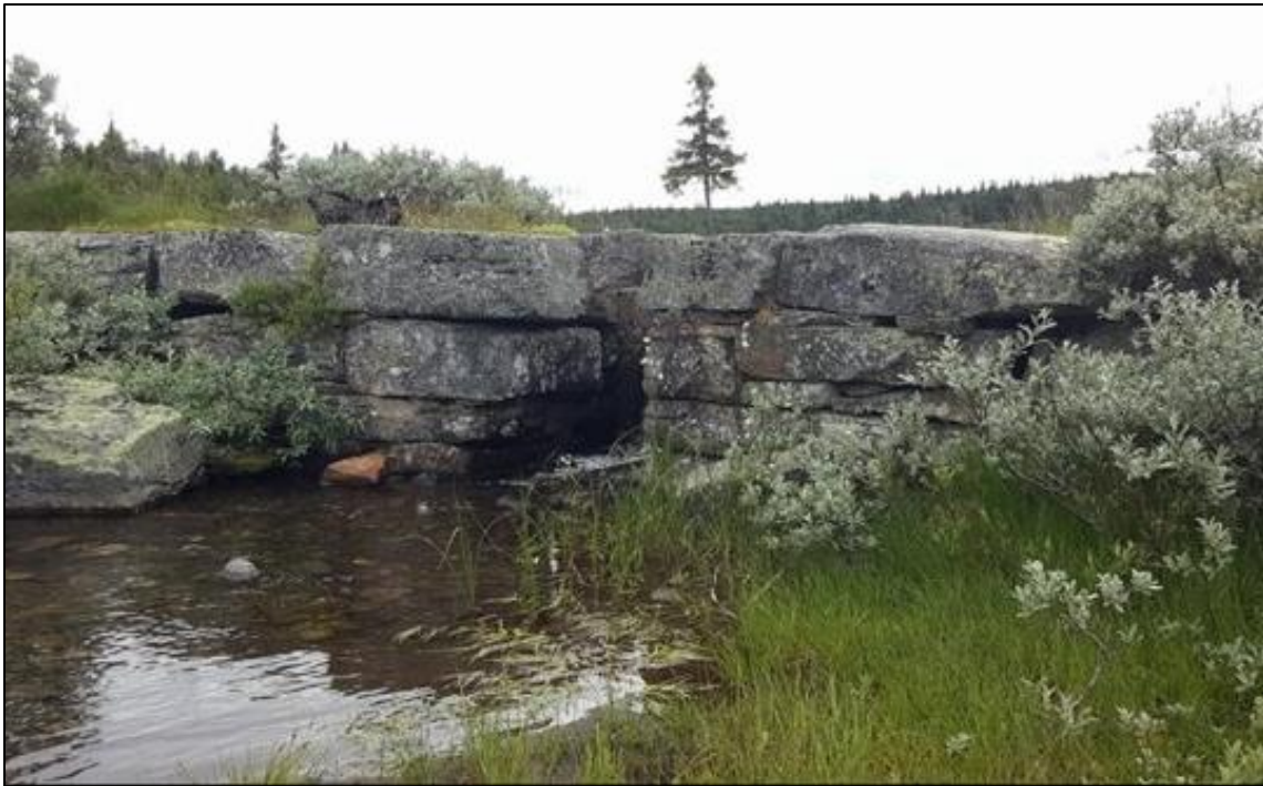
Figur 1: Bilde av eksisterende dam ved utløp Svintjønna.
