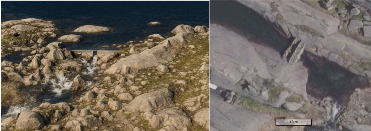
Skjermdump av konsesjonssøknaden (T.V.) og ortofoto av eksisterande demning ved Seltuftvatn, bak Storehesten (T.H.)
