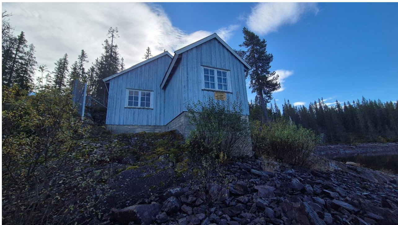
Figur 1-3. Lukehuset som skal rehabiliteres, dette ligger i østenden av den planlagte veien.
