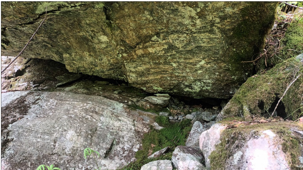
Figur 28: Biletet viser sprekkdanninga i underkant av blokka øvst i skaret (infopunkt 7). Fjellet som ligg under blokka er massivt og utan sprekkdanning, og det er lite lausmassar i underkant av blokka. Dette indikerer at det har vore lite til ingen bevegelse i blokka på veldig lang tid, og det er tolka at blokka har lege stabilt i fleire tusen år.
