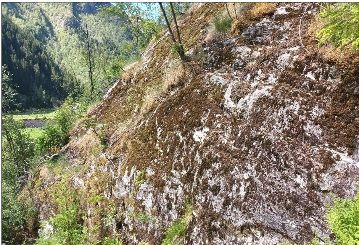
Figur 7: Biletet viser delar av fjellskråninga i nordvestleg del av påverknadsområdet. Bergarten er tolka å vere granodiorittisk gneis, og er vurdert som massiv og utan vesentleg sprekkdanning i dette området. Infopunkt 3.
