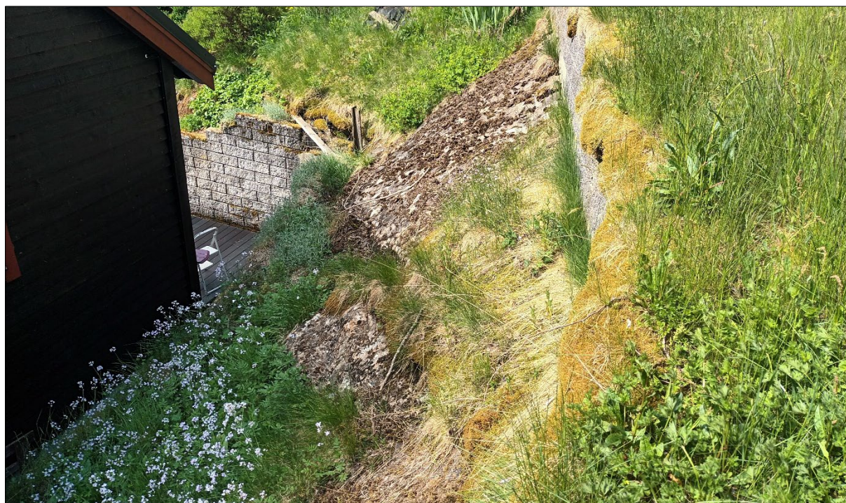
Figur 26: Den nordaustlege fjellskråninga strekk seg ned til bakkant av bustadhuset i kartlagt område. Fjellskråninga er vurdert som massiv og utan sprekkdanning i heile det observerte strekket. Infopunkt 2.
