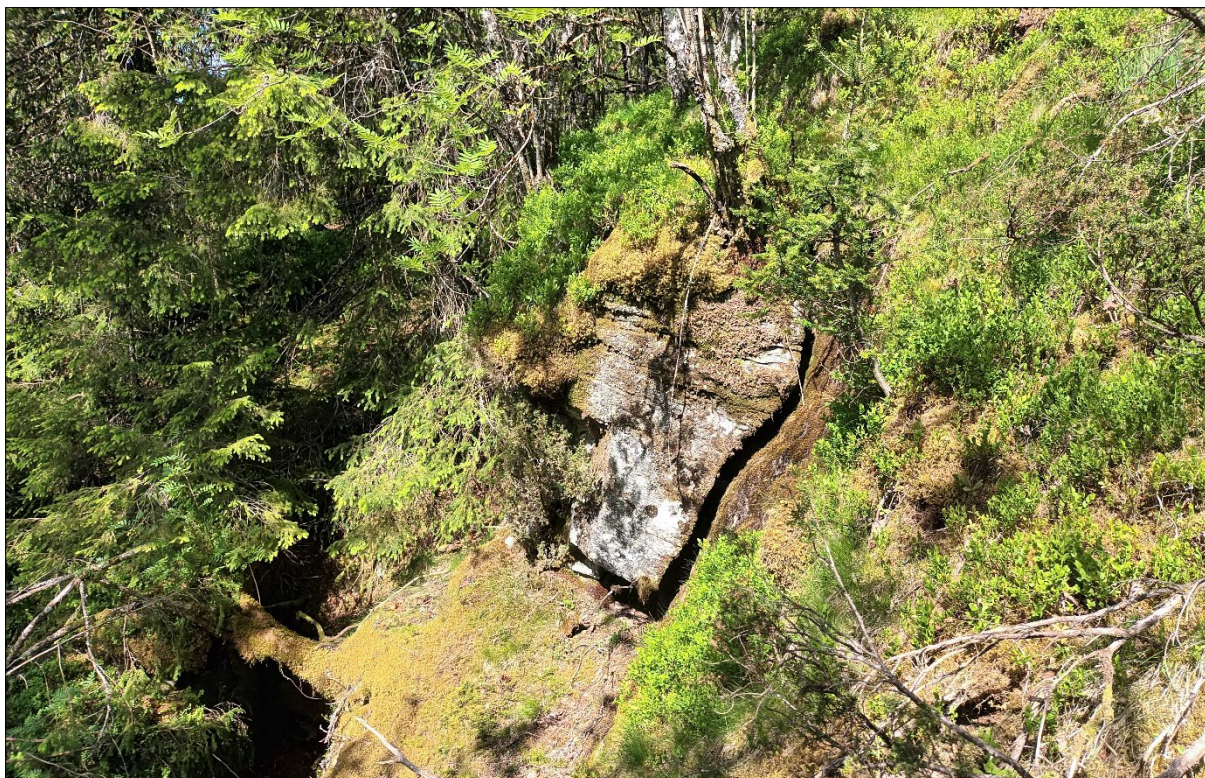
Figur 10: I øvre del av hammarpartiet vart det observert nokre avløyste og tilnærma avløyste blokker. Størsteparten av blokkene observert i felt er vurdert å ligge stabilt, og er tolka å vere knekt direkte ut frå fjellet truleg grunna avlasting etter nedsmeltinga av siste istid. Infopunkt 8.
