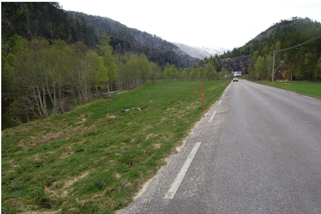
Riggområder RS-2 til venstre og RS-1 til høyre
