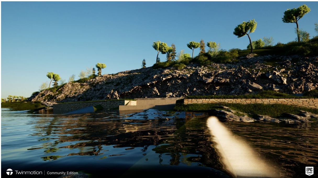
Dam og inntak sett fra vest mot øst
