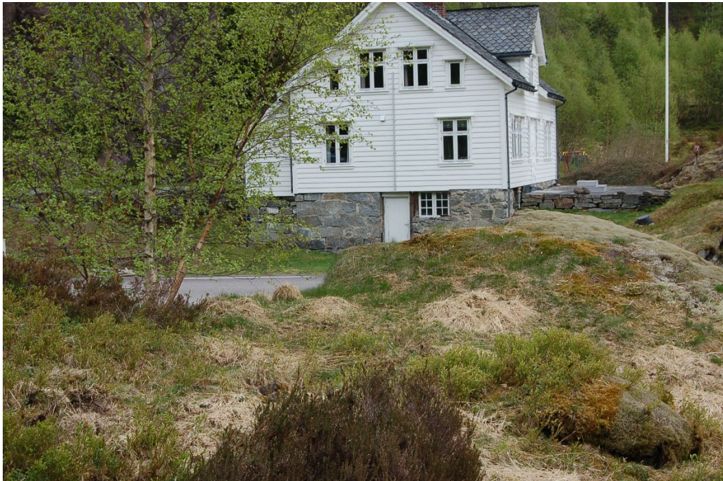
Enebolig, sett fra stasjonstomten
