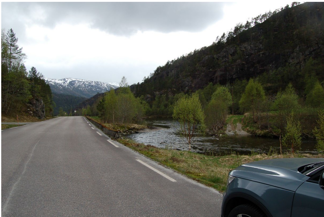
Ser ned mot riggområdene RS-1 og RS-2, merkbar innsnevring av Dalelva midt i bildet
