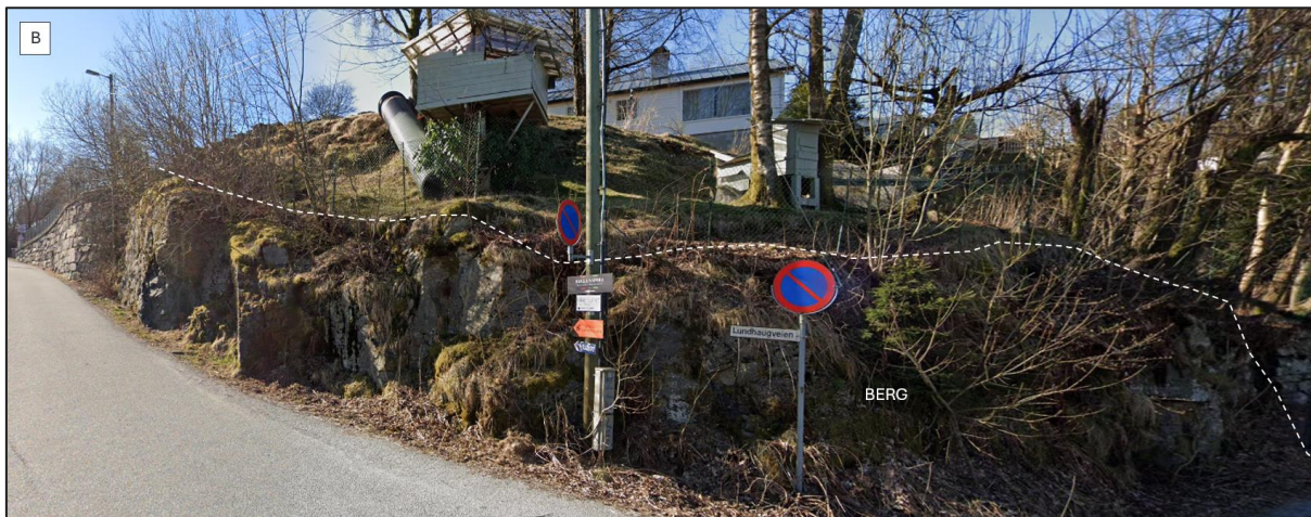
Figur 3-5: Berg i dagen ved lokasjon B i Figur 3-3. Kilde: Google Streetview [12]
