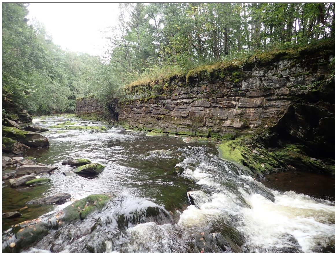
Figur 4-1: Mur som er et statlig listeført, teknisk/ industrielt kulturminne og en del av den lokale gårdshistorien. Foto: Sweco.
