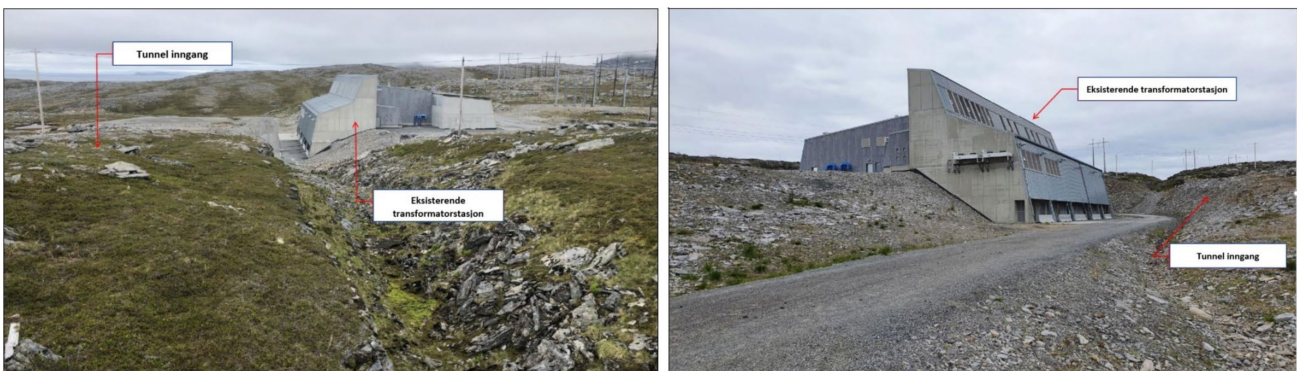
Figur 2-2 Oversiktsbilde over eksisterende 132 kV transformatorstasjon på Hyggevatn (Lucerna), markert med planlagt tunnelinngang (Snøhvit Unit).
