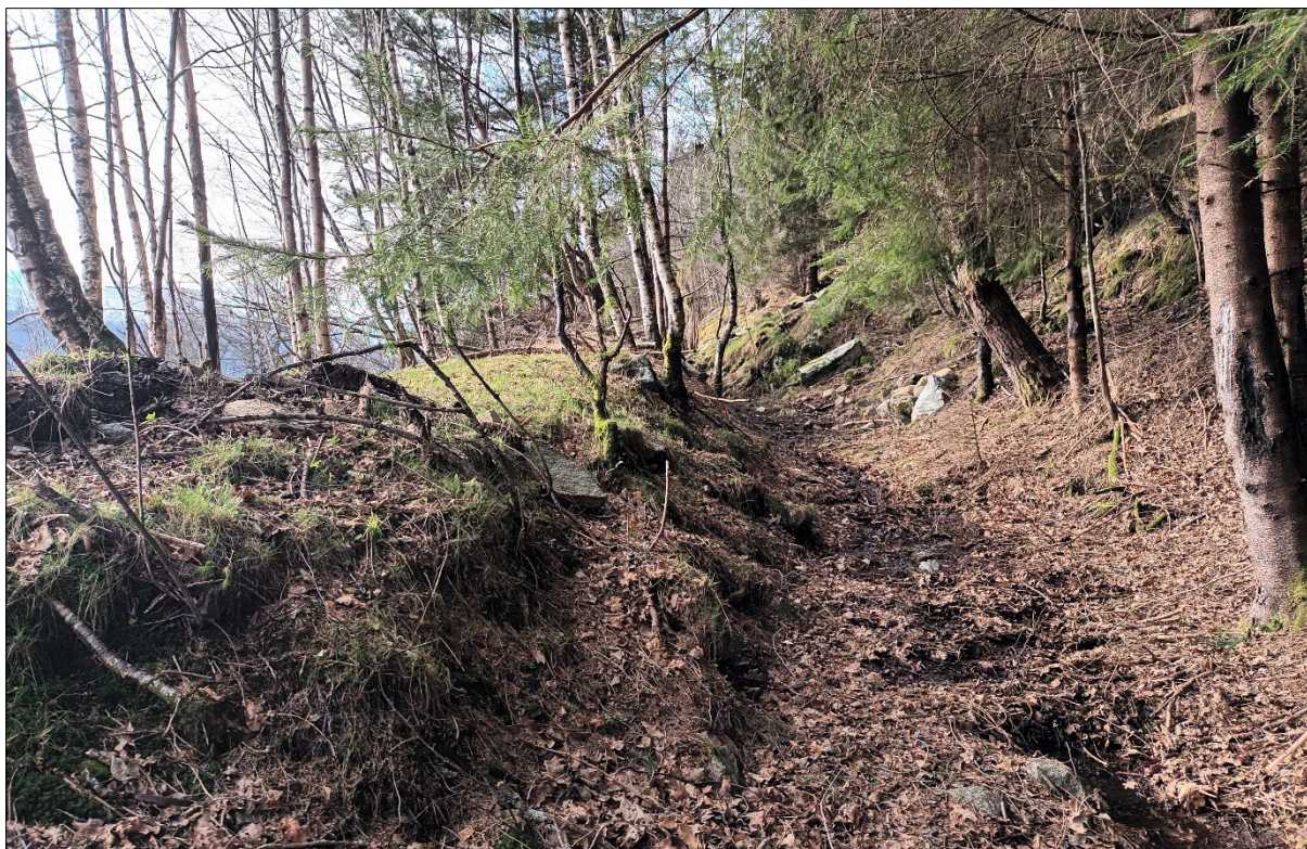
Figur 14: Fangvollen overfor kartlagt område (infopunkt 3). Steinsprangblokker observert i felt var hovudsakleg lokalisert på nordsida av vollen.
