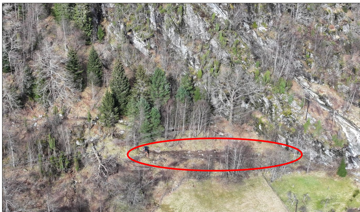
Figur 27: Det vart observert nokre enkelte blokker på sørsida av fangvollen ovanfor kartlagt område, men desse er vurdert å ha blitt greve fram i samband med ein skogsveg (raud markering) nedanfor vollen. Infopunkt 2.
