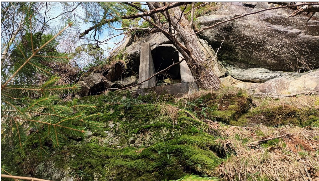
Figur 29: Rett nordaust for fangvollen er det satt opp ein betongstruktur i fjellsida, antatt å vere sett opp som støtte for eit fjellparti med overheng. Infopunkt 4.
