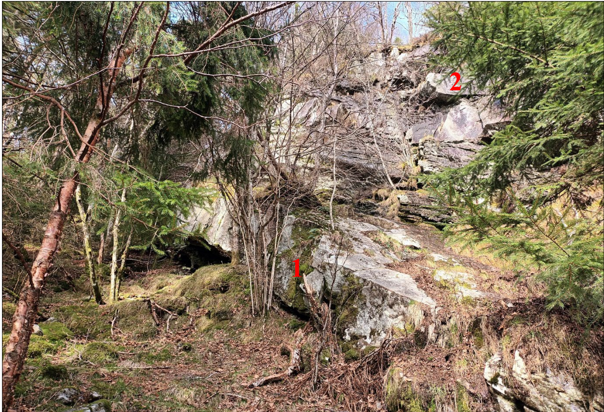
Figur 9: Midtre del av hammarpartiet ved Gautegjelet. Den synklinale faldinga har ført til oppsprekking langs foliasjonsplana. Grunna den generelt massive bergarten er sprekkavstanden stor (~1 meter), og det er danna større flakdanningar i nedre del av fjellpartiet (1). Sprekkeavstanden er kortare høgare oppe i hammaren (20 – 50 cm), men fallet i foliasjonsplana er slakare, noko som fører til meir horisontal sprekkdanning (2). Infopunkt 7.
