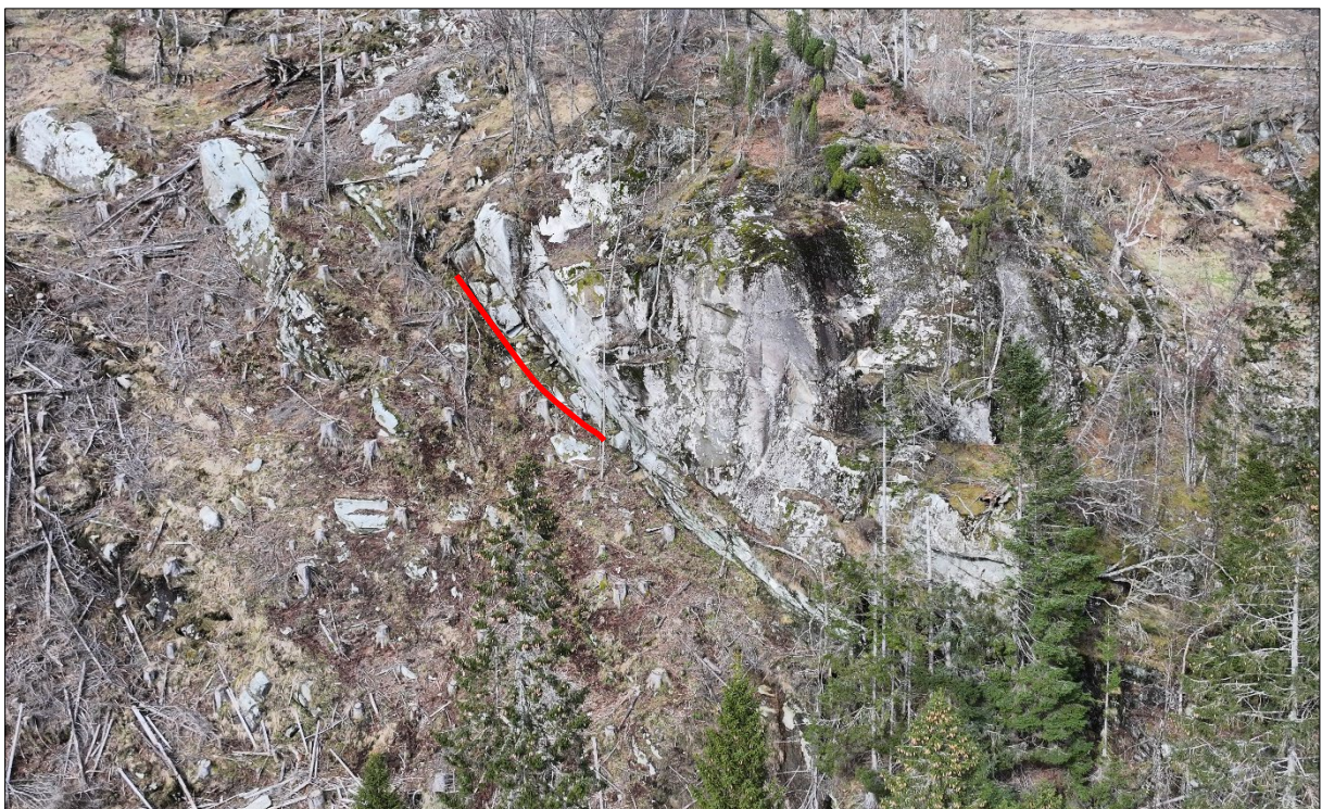
Figur 8: Øvre del av hammarpartiet ved Gautegjelet. Berggrunnen har høg sprekkdanning i nedre del grunna ei synklinal falding som går under fjellet (raud markering). Infopunkt 7.
