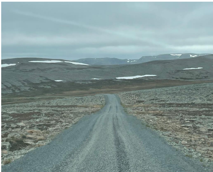
Figur 6. Viser deler av adkomstveien til Kjøllefjord vindpark, etter man har tatt av fra Fv894. Foto: Fred. Olsen Renewables
