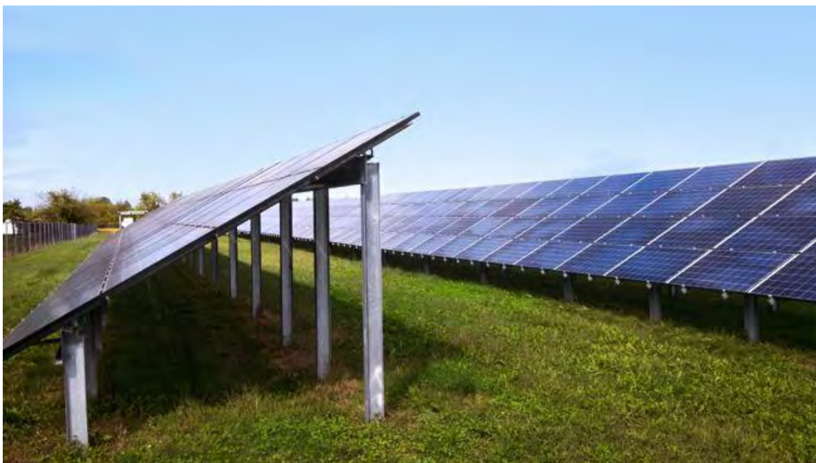
Figur 2-3: Fast-vinkel installasjonsløsning (foto: Willowbrook Solar).
