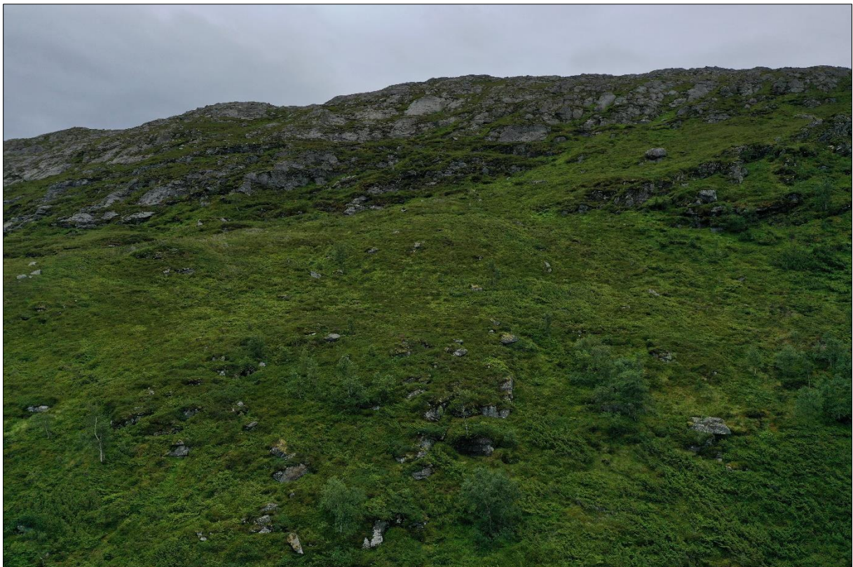
Figur 8: Nedanfor øvre del av fjellsida er det ei flate som i lag med relativt massivt fjell utan overheng reduserer sannsynet for utfall frå denne delen ned mot kartlagd område.
