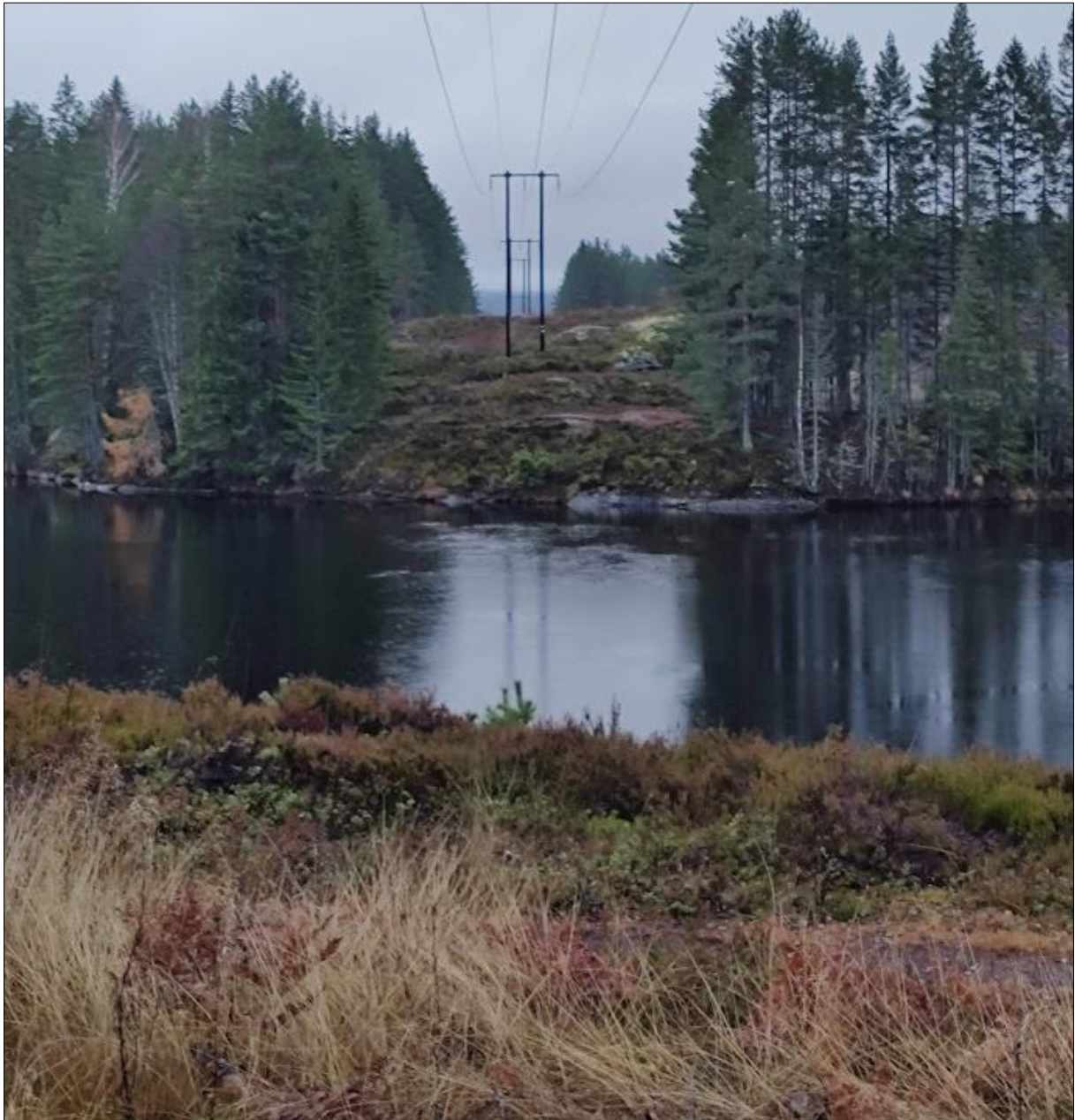
Figur 69. Bilde tatt mot sør, fra plassering av mast 11 mot 12. Fjell langs elvebredden og på flaten i bakkant av mast 12 og videre mot 13 og 14.
