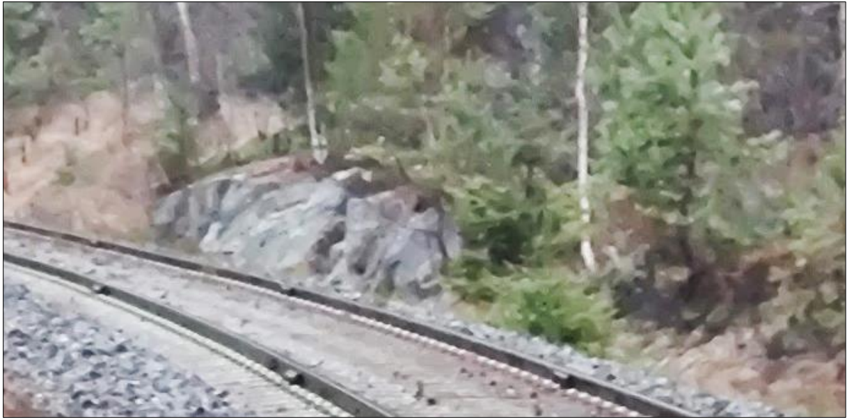
Figur 44. Fjellskjæring langs jernbanelinjen mellom mast 43 og 44.
