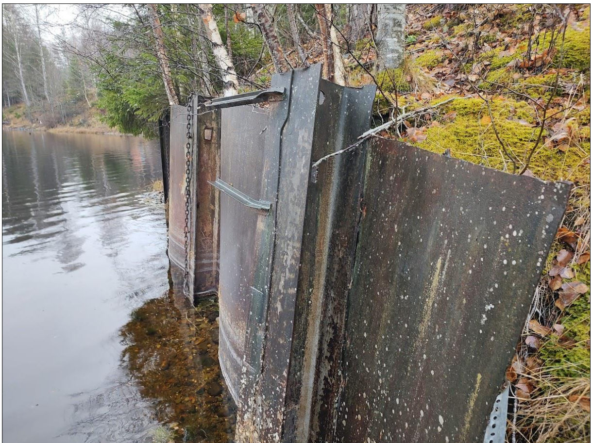
Figur 52. Spunt stabiliserer løsmasseskråning sørøst for mast nr. 9. Trolig fra tid hvor med tømmerfløting var vanlig.
