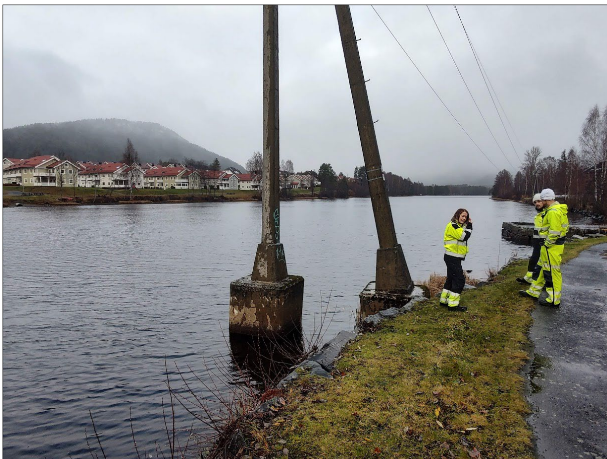
Figur 15: Plassering av eksisterende mast 19. Den nye masten er plassert i elva. Det anbefales spunting for utgraving eller masten fundamenteres på peler.
