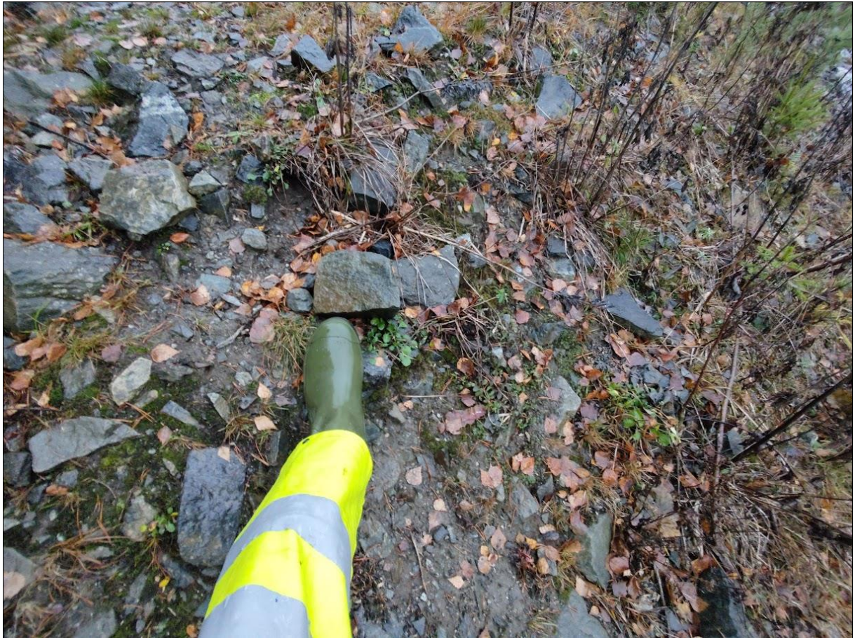
Figur 75. Bildet illustrerer typisk størrelse på plastringsteinen mot elva nedenfor mast 27.
