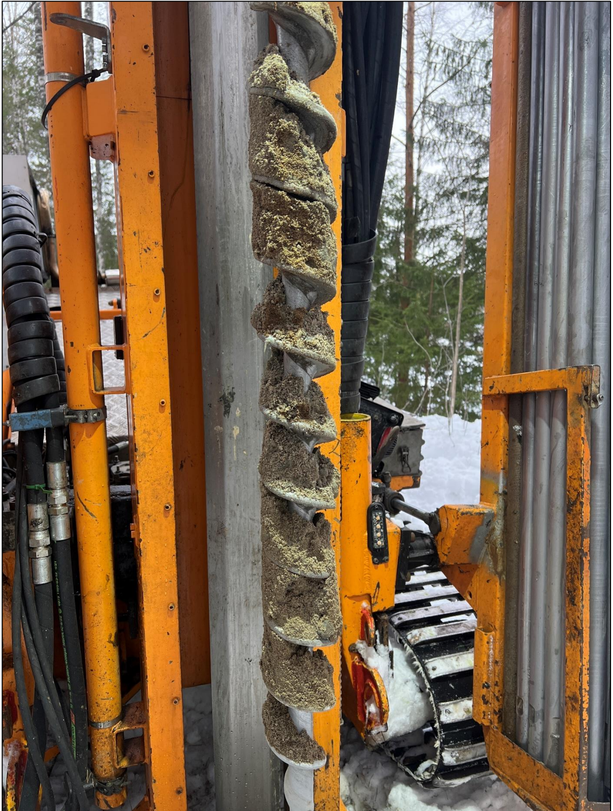
Figur 20. Borepunkt 11. Dyp 3-4 m. Foto: Romerike Grunnboring.
