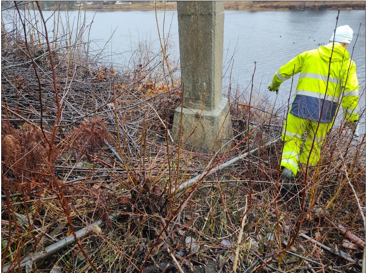
Figur 58. Mast nr. 17 med fundament som tyder på at det står på fjell. Bildet tatt mot øst, over Numedalslågen.
