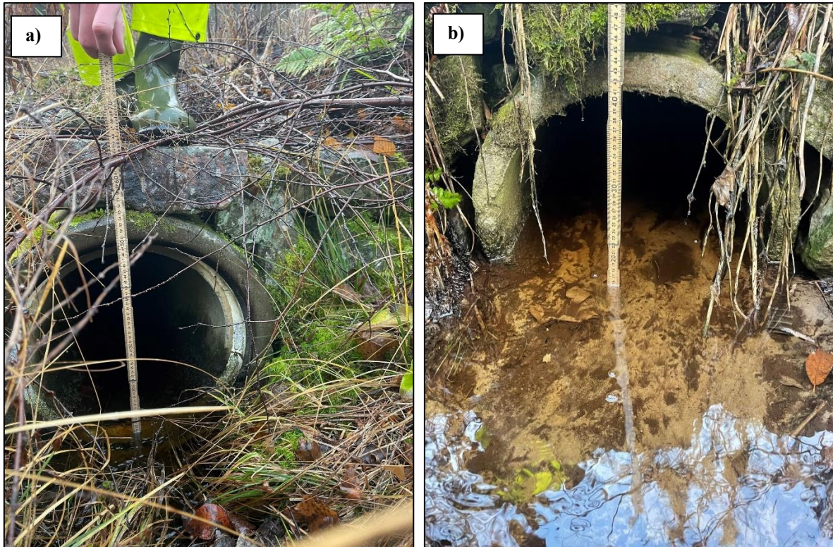
Figur 18: Innløp (a) og utløp (b) til kulvert i bekken ved M48.
