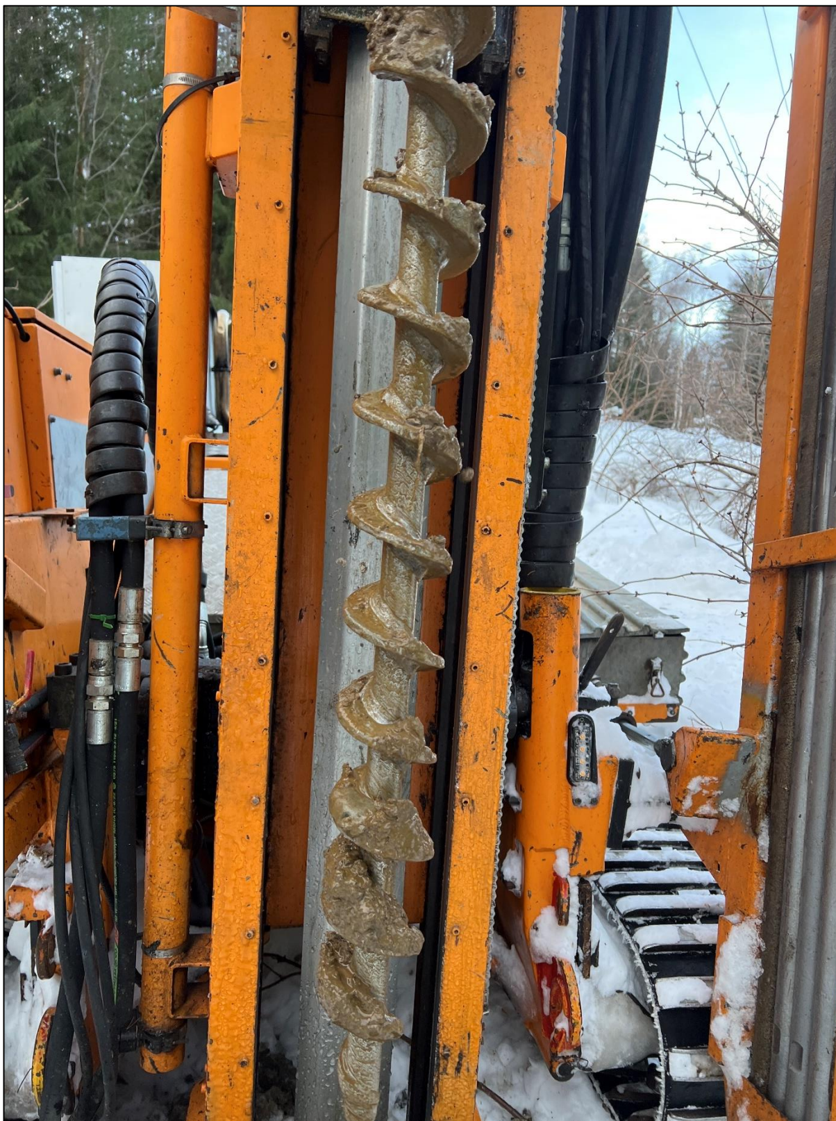
Figur 24. Borepunkt 13. Dyp 3-4 m. Foto: Romerike Grunnboring
