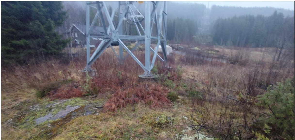
Figur 45. Mast nr. 42 fundamentert på fjell.
