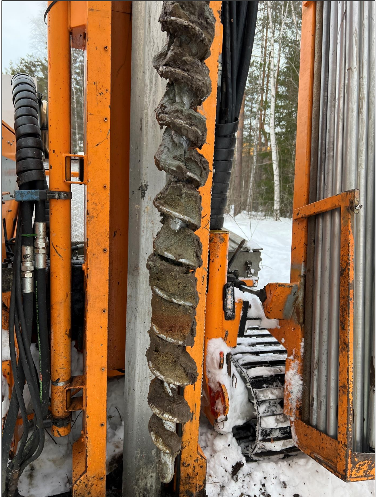
Figur 29. Borepunkt 14. Dyp 2-3 m. Foto: Romerike Grunnboring
