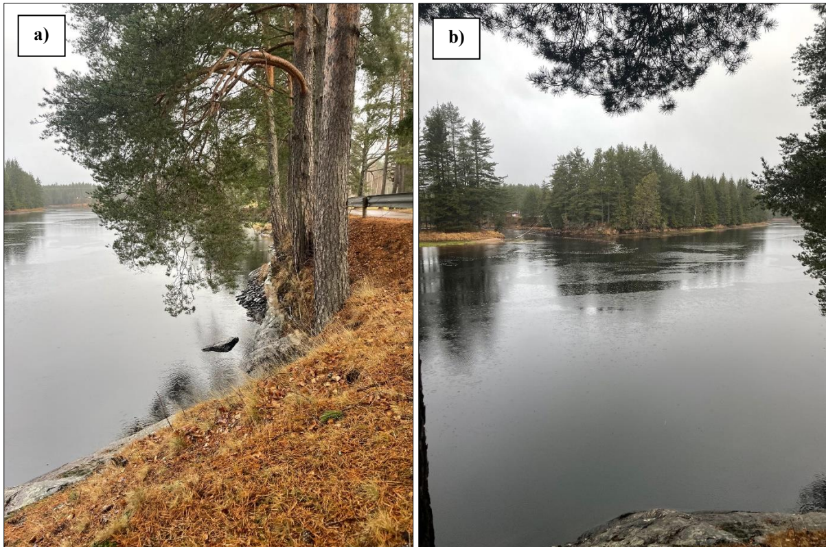
Figur 11: a) Oversvømt vei oppstrøms for mastepunkt M50 på strekningen Nordre spiten – Stengelsrud under flommen i 2007 og b) krysningspunkt mellom Jondalselva og Numedalslågen (bilder tatt under befaring 16. november 2022).
