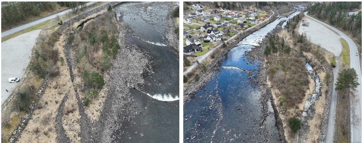
Figur 15. Dronebilder av løpet sett nedstrøms (venstre) og oppstrøms (høyre).
