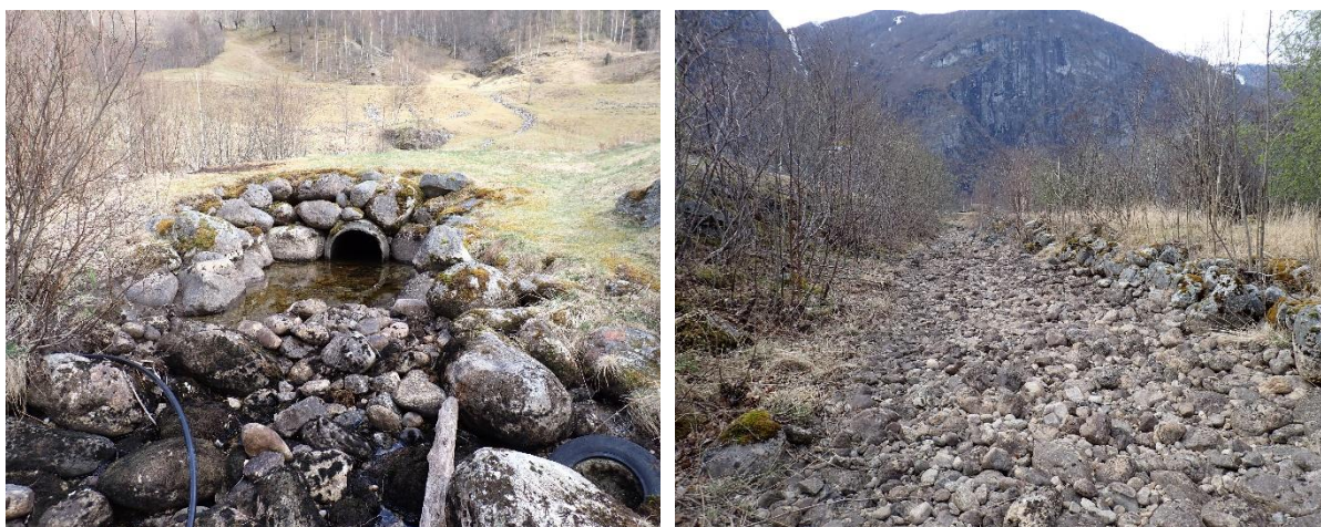
Figur 12. Bilder av sideløpet ved Måbødalen camping. Venstre: Inntaket til sideløpet sett oppstrøms. Høyre: Bilde lenger nedstrøms hvor løpet fremstår som helt tørrlagt.
