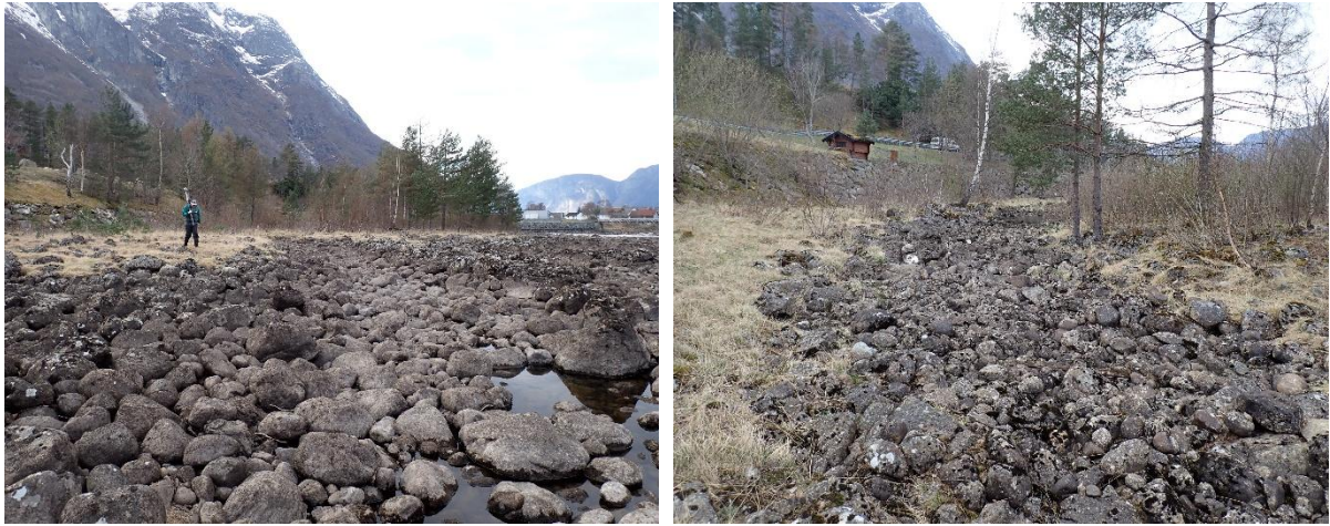
Figur 14. Bilder av sideløpet ved Kjernøya i Eio. Venstre: Innløpsområdet inn til flomløpet fra Eio. Høyre: Bilde tatt ned mot midten av løpet hvor det finnes en kulp/renne som holdt vann på befaringstidspunktet.
