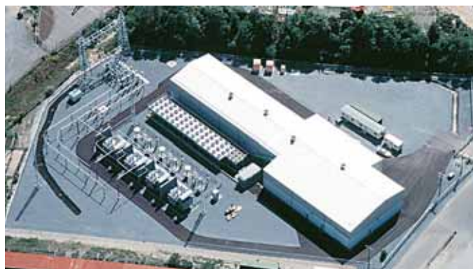
Figur 9. HVDC light® strømretteranlegg ved Shoreham i New York. Kilde: ABB.
