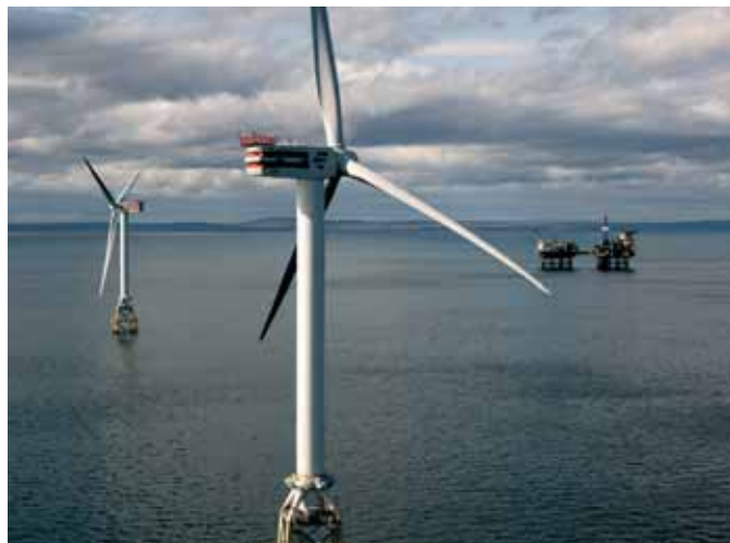
Foto av OWEc Tower med 5 MW Repower vindturbin installert ved Beatrice plattformen i Skottland. Kilde: www.beatricewind.co.uk .
