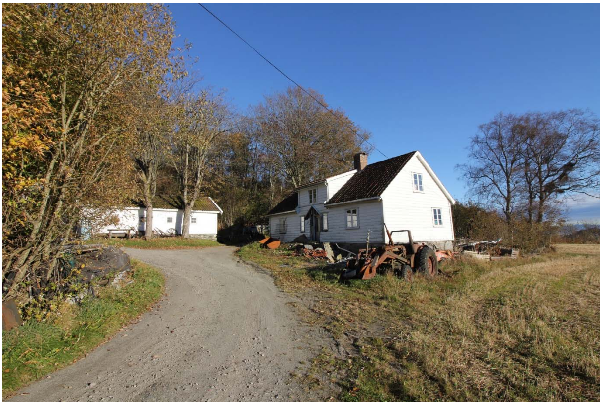
Figur 37. Gardstunet til gbnr. 49/2, med våningshus (SEFRAK 11270302005) til høyre og vaskehus (SEFRAK 11270302006) til venstre. Mot nord.
