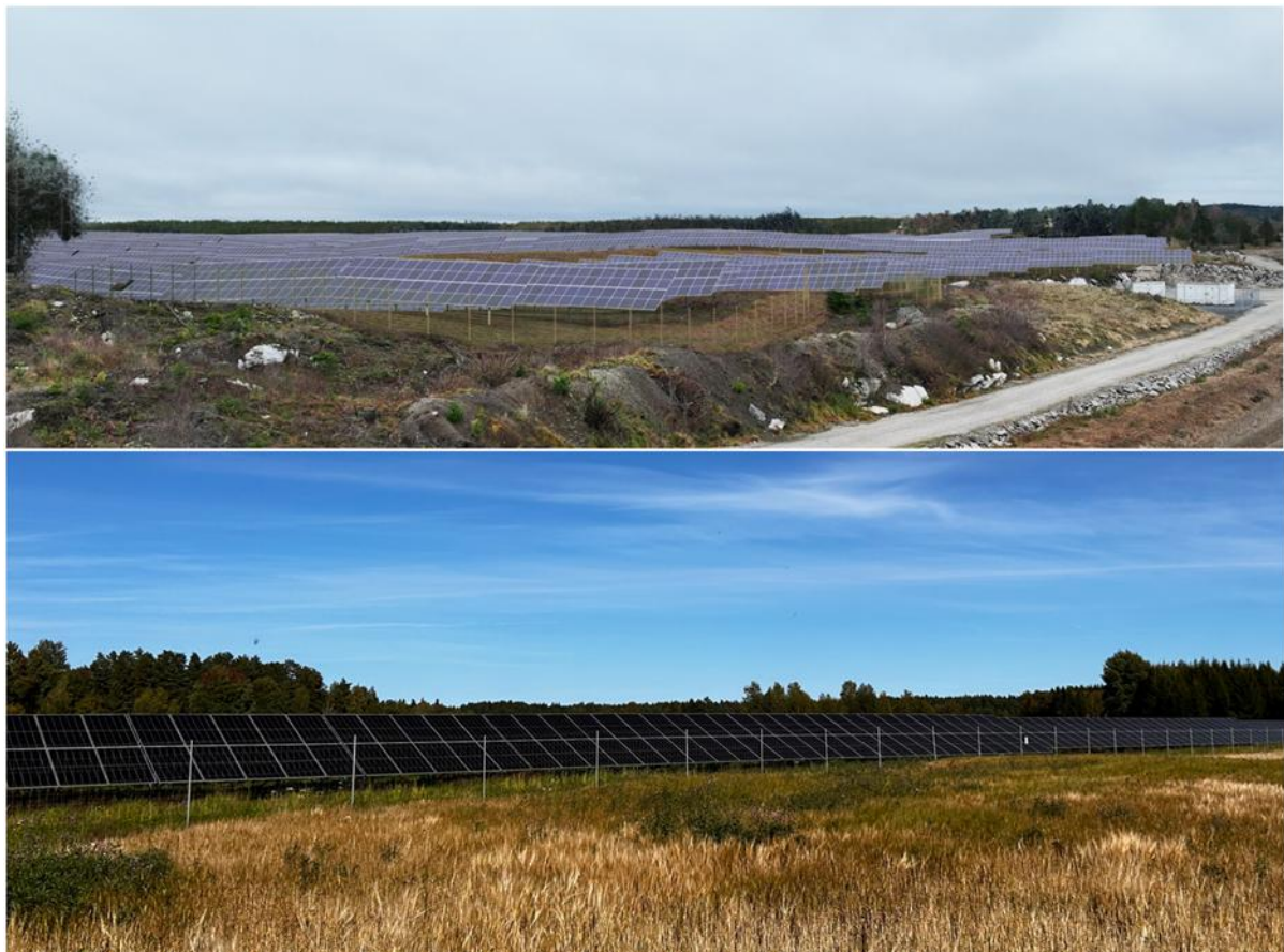
Figur 13 - Inngjerding av solkraftverk
