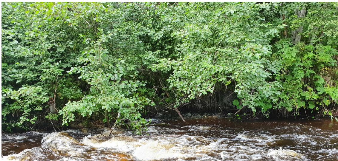
Figur 5 – B3; litt erosjon på skråningsbunn, men det observeres steiner på tåen og elvebunn
