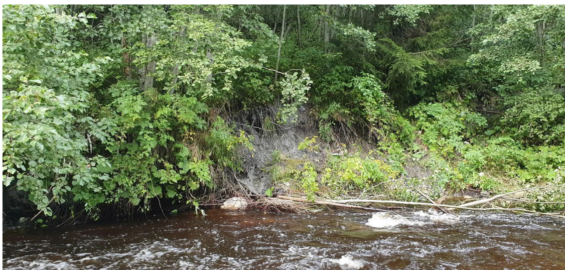
Figur 8 – B4; noe erosjon; jordarter ser blanding av kohesjons- og friksjonsjordarter.
