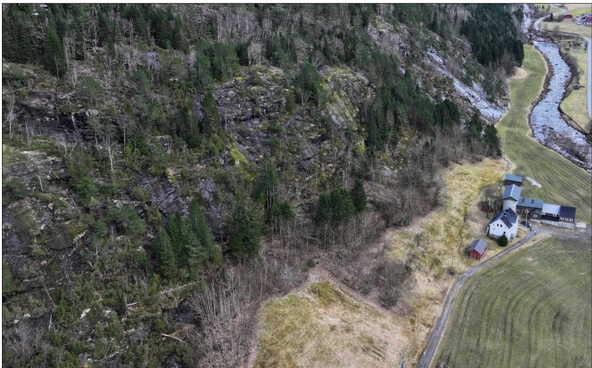
Figur 8: Fjellskråninga nord for kartlagt område er vurdert som massivt, utan vesentleg sprekkdanning. Det er stadvis spor etter forvitring langs foliasjonsplana, men ingen gjennomgåande store sprekker.
