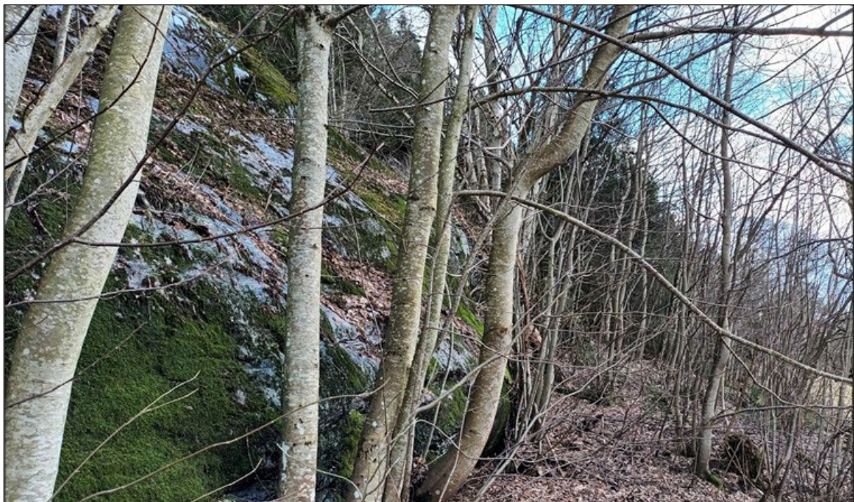
Figur 26: Fjellskråninga i nord har ei glatt overflate og er vurdert som massivt, og det er ikkje observert vesentleg sprekkdanning.
