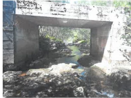
Figur 8 Bro til beite, kjørbare. 3,2 m høy med lengde på 5,1 m
