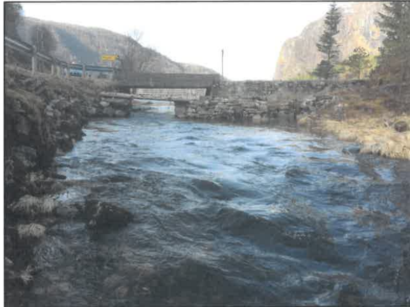
Figur 4 Vassdraget nedstrøms tenkt damplassering. Fv607 til venstre i bilde
