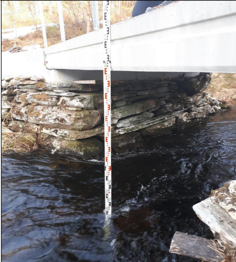
Bilde 6. Ny bru ca. 300 meter nedstrøms Ramsgrovatnet. Brua er etablert på tidlegare landkar og har ein lysopning på 2,8 meter lengde og 1,95 meters høgde (bilde frå 2018).
