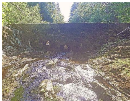
Bilde 1. Nedstrøms damside. Hentet fra søknad 2020.
