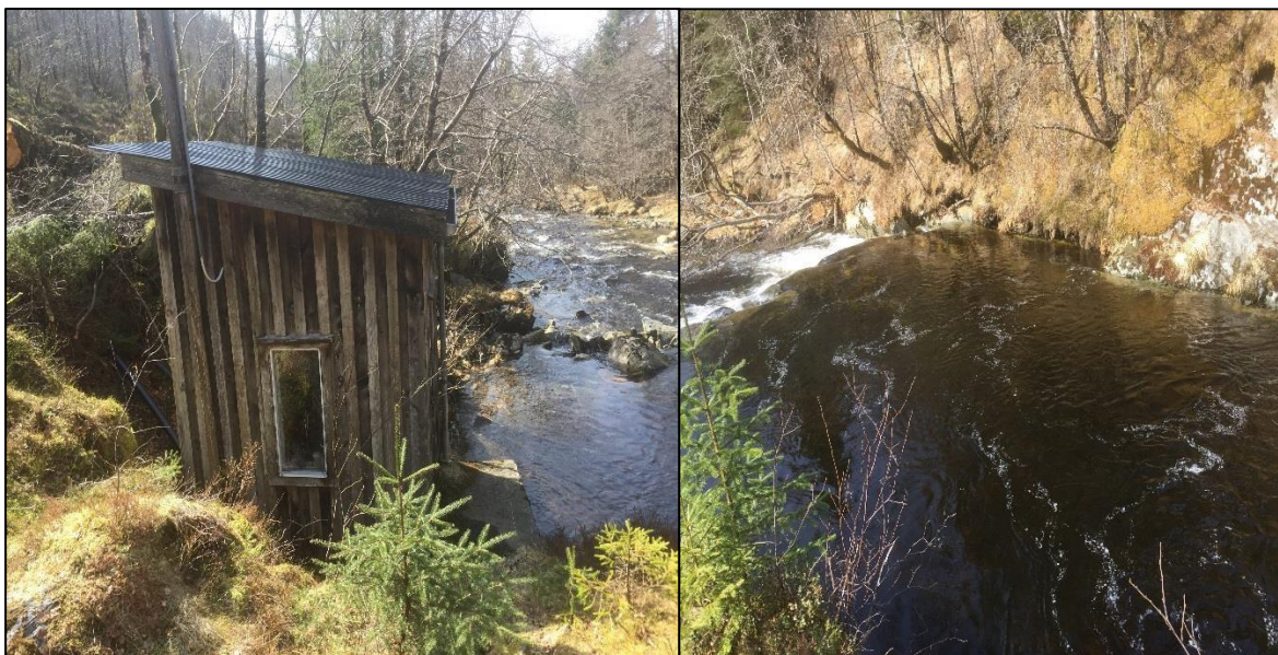
Bilde 15. Gammel nedlagt privat pumpehus for vassforsyning til Sørbøvåg. Inntaksdam laget av store blokker. Kommunen overtok vassverket for en periode frem til nytt vassverk ble etablert (bilde frå 2018).
