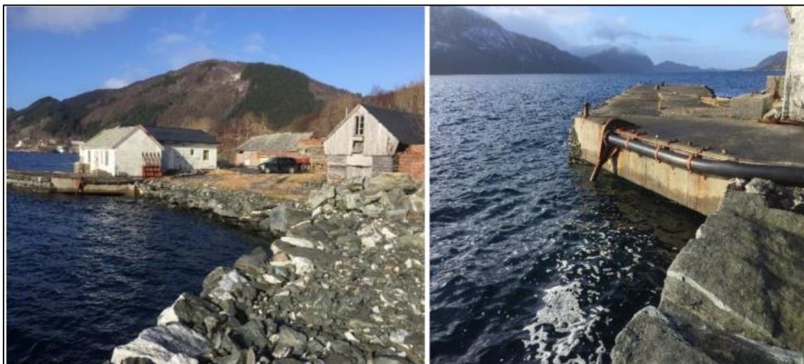
Bilde 33. Gammelt settefiskanlegg og nærbilde av kai til høyre med Åfjorden i bakgrunnen (bilde frå 2018).
