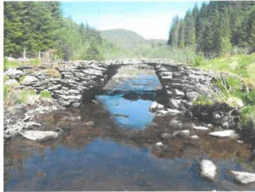
Figur 5 Bro til beite, 1,8 m høy med lengde på 2,2 m
