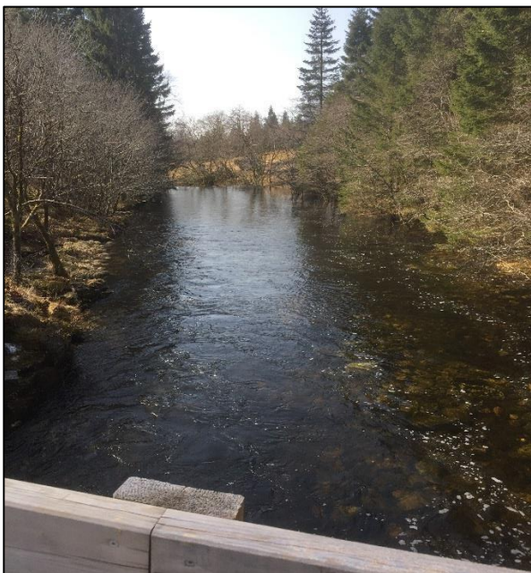
Bilde 16. Trebru/gangbru og sikt mot bilde nr. 16. Brua er nytta som tursti (bilde frå 2018).
