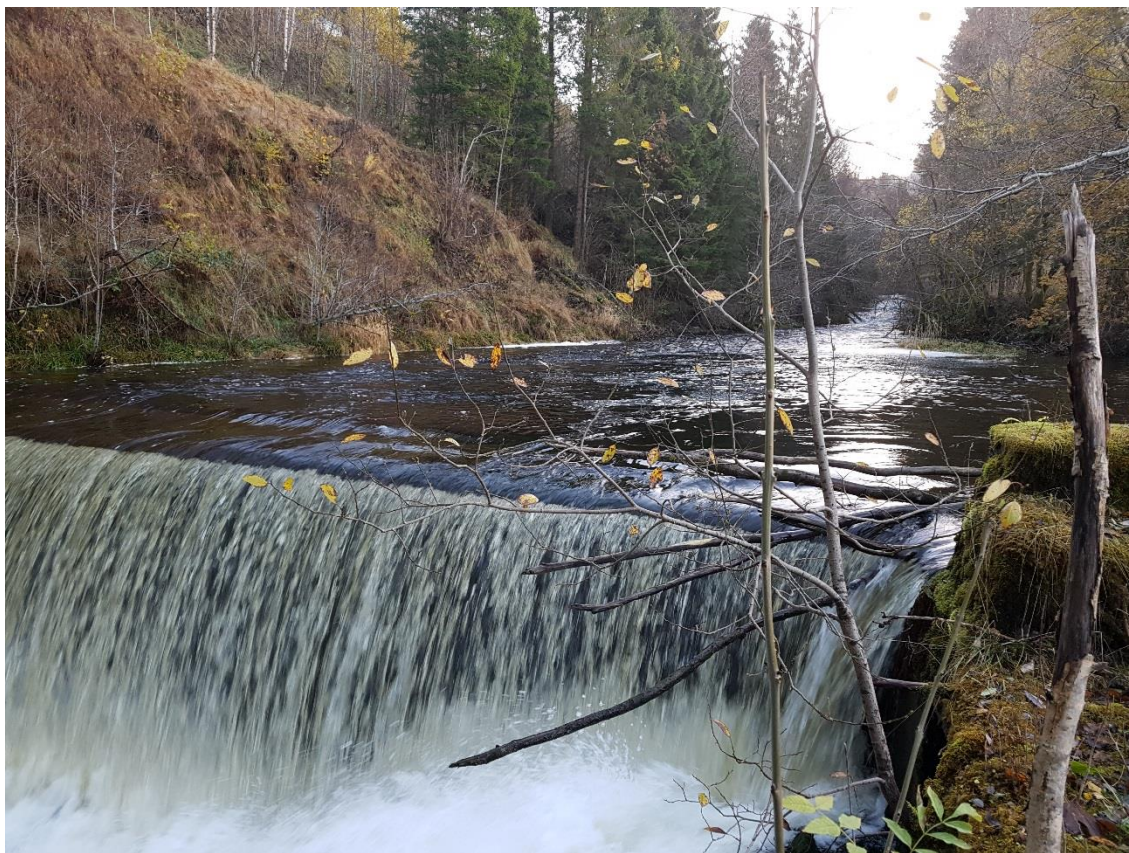
Figur 9. Kvia dam sett mot nord-øst. Foto: Sweco.
