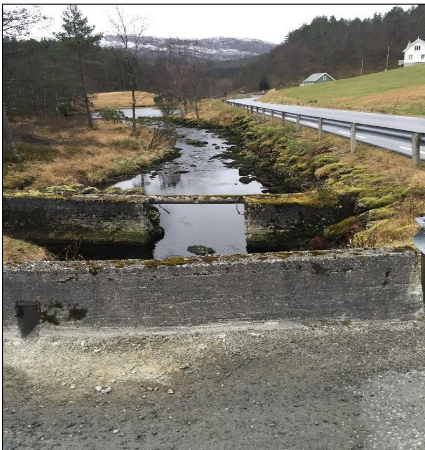
Bilde 5. Bildet er tatt frå Høydalsbrua som vises godt i bilde nr. 4 og en ser nedover elva. Det var liten vassføring i Salbuelva då bilde ble tatt (bilde frå vår 2018).
