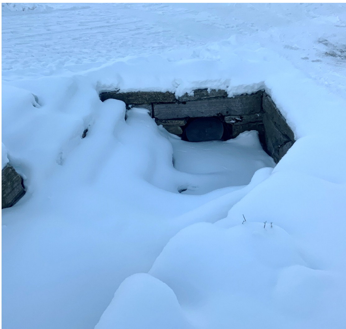
Figur 5-4 Ø600 mm overvannsrør som er lagt under gårdsplassen. Bilde er tatt ved punkt 56 vist i figur 5-2.
