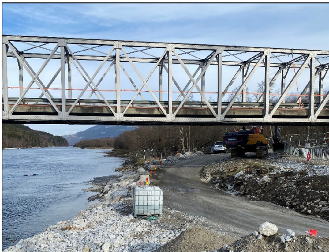
Figur 1: Anleggsvei i elveløpet under bruene på Randklev. Foto fra søknaden.
