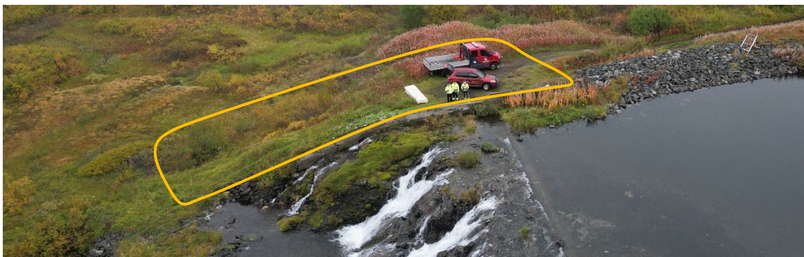
Figur 4.1 Riggområde vest for dammen markert i orange. Markering inkluderer eventuell utstrekning av skråninger.
