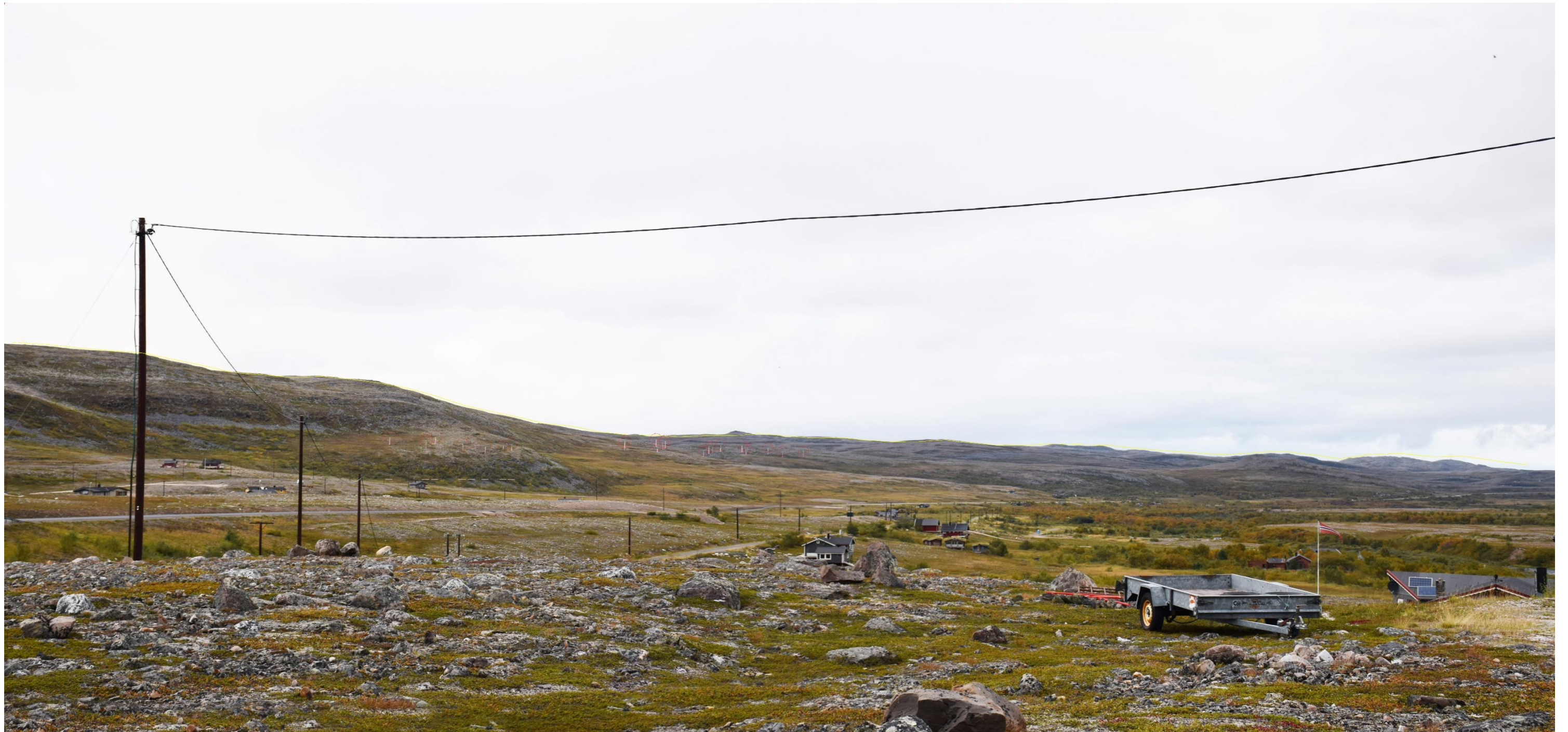
Kongsfjorddalen UTM35 7837599 579654. Foto 7. september 2022 Trine Riseth, Multiconsult. Visualisering av utbygging alternativ nord med 23 turbiner , Eva Hjerkin, Multiconsult. Avstand til nærmeste turbin 16,7 km.
