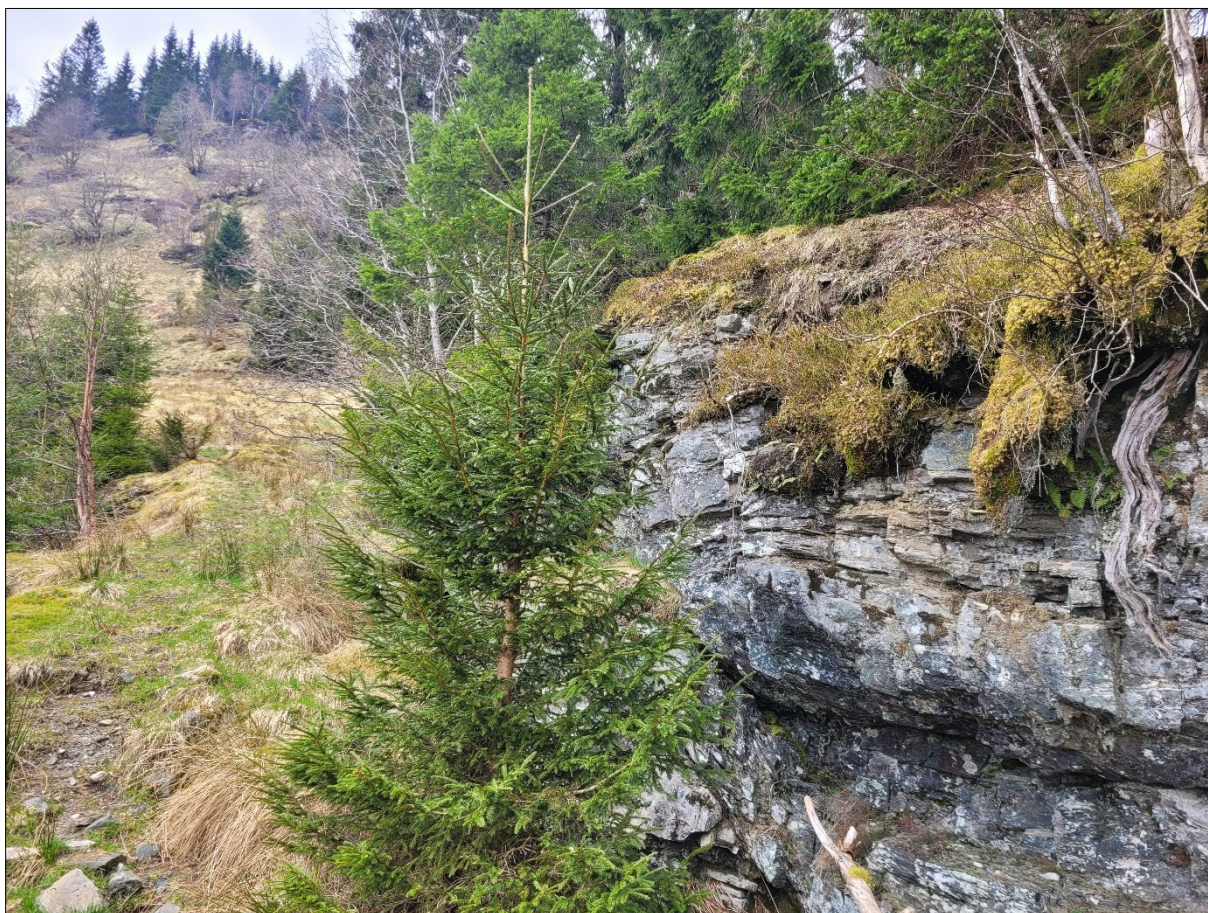
Figur 9: Nærbilde av kvartsskifer i påvirkningsområdet. Berggrunnen er kraftig oppsprukket og hovedsprekkeplan følger foliasjonen til bergarten.
