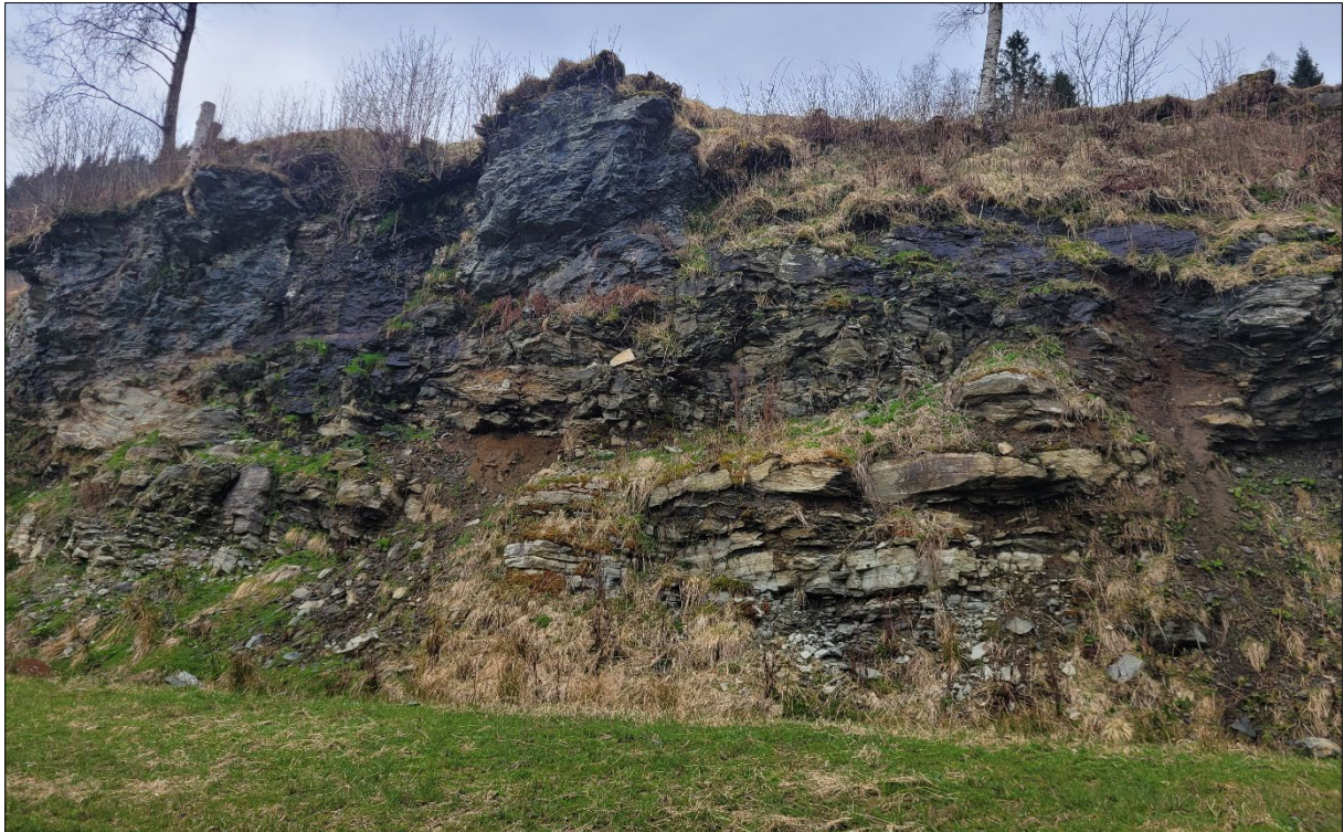
Figur 7: Bildet viser fjell i dagen i nedre deler av påvirkningsområdet, omtrent 70 m nord for kartlagt område. Berggrunnen består av kvartsskifer (lys grå/brun) og metagabbro (mørk grå/svart), som er kraftig oppsprukket. Infopunkt 1.
