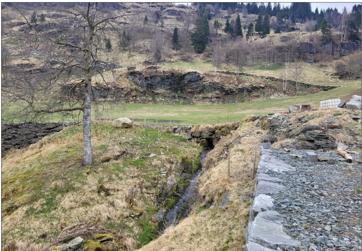
Figur 14: Dreneringsvei fra Alefjellet der nedre deler av bekkeløpet er lagt i rør, med utløp nordvest for kartlagt område. Infopunkt 3.
