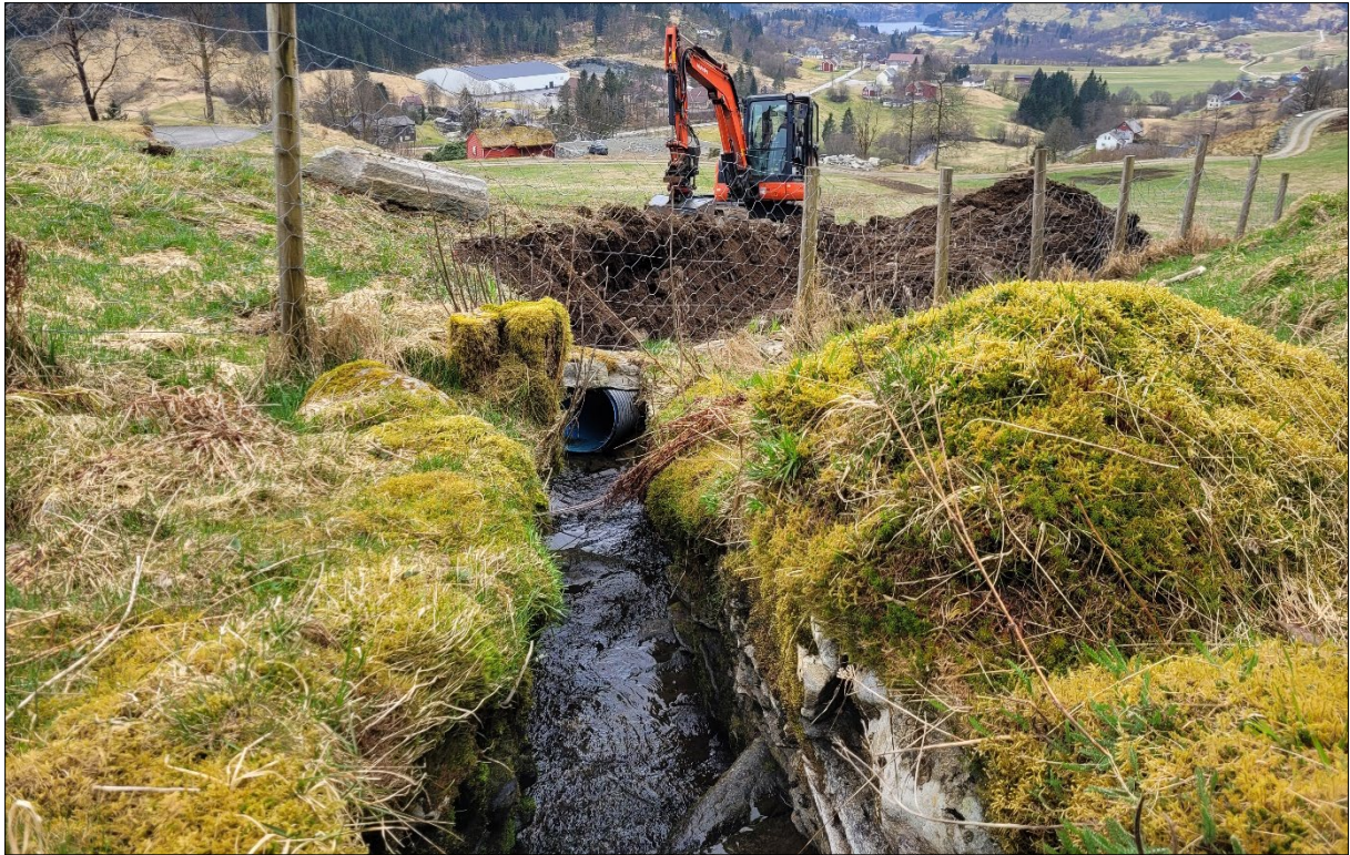
Figur 13: Bildet viser deler av bekkeløpet fra Alefjellet. Herfra, omtrent 120 moh. (infopunkt 2), drenerer bekkeløpet i rør med en åpning på 44 cm. Bekkeløpet har utløp nordvest for kartlagt område (infopunkt 3).
