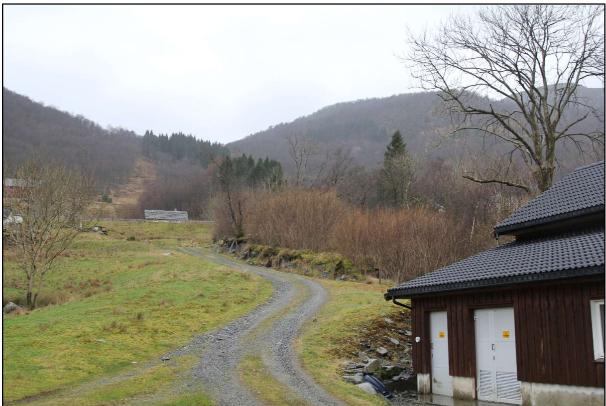
Figur 8. Nedre del av nedgraven rørtrasé for Vaka kraftverk. Foto 27. november 2022.
