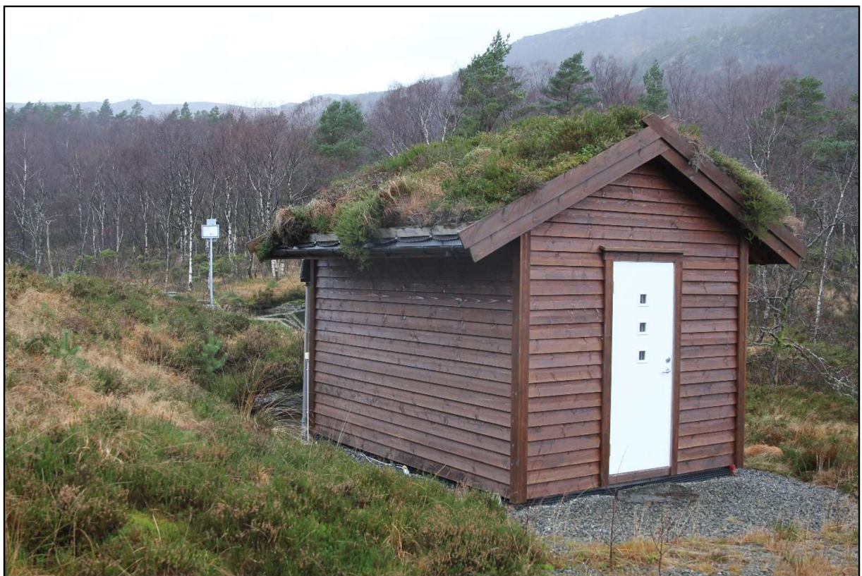
Figur 6: Eksisterande damhytte ved inntaket i Vakaelva, kote 263. Foto 27. november 2022.
