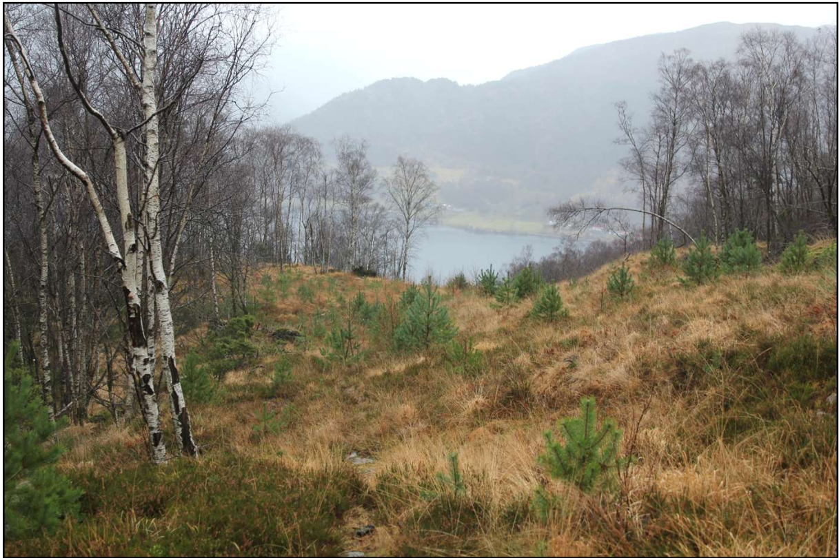
Figur 7. Øvre del av nedgraven rørtrasé for Vaka kraftverk. Foto 27. november 2022.
