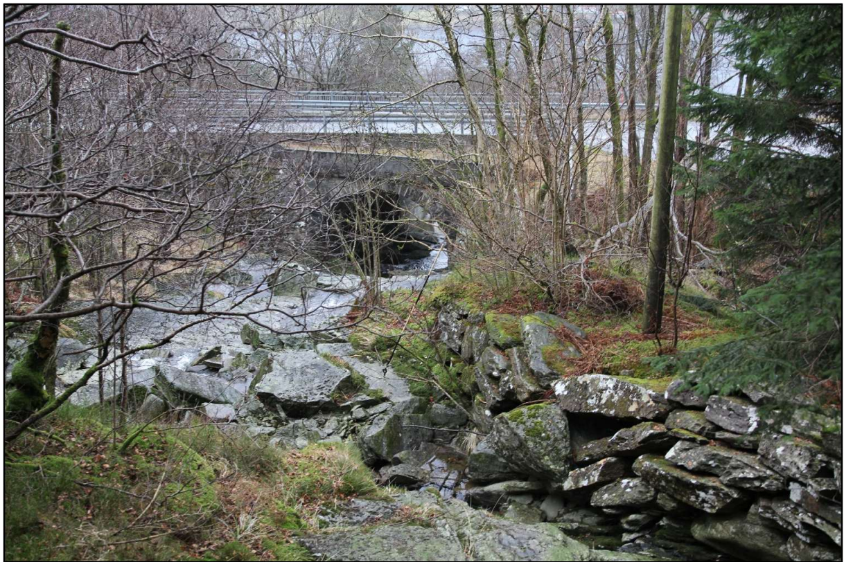
Figur 10. Vakaelva med sideløp kring kote 30-35. Fv543 mellom Ølensvåg og Utbjøa kryssar vassdraget i bakgrunnen. Foto 27. november 2022.
