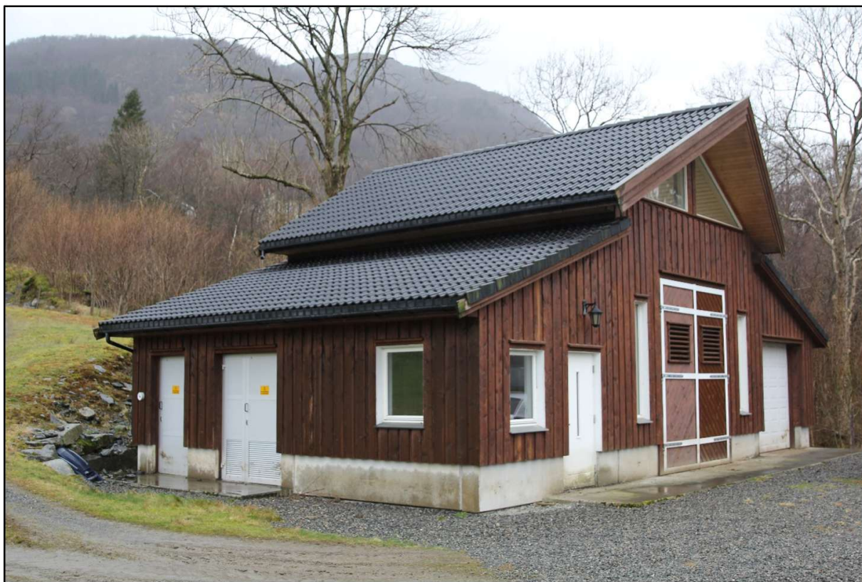
Figur 4. Vaka kraftstasjon, kote 5, ferdigstilla i 2014. Foto 27. november 2022.
