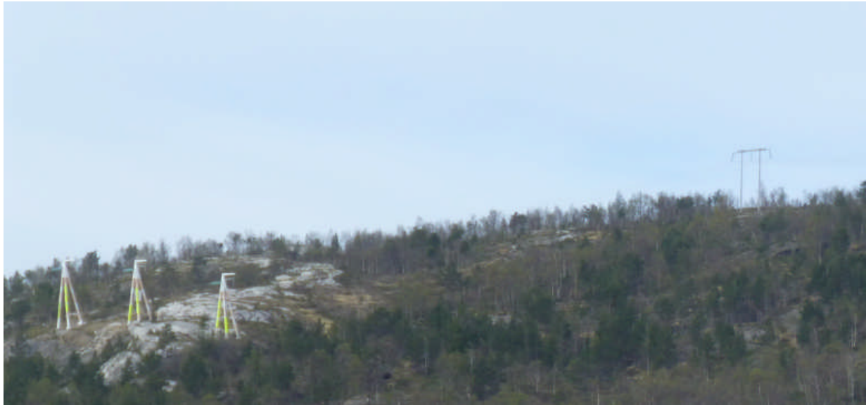
Figur 3-8 Bilde av eksisterende master ved 132 kV fjordspenn over Saltstraumen
