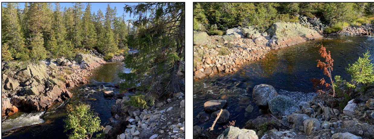
Figur 5-2 Inntaksterskel. Dato: 07.09.2022., 09:42, Q = 0,84 m 3 /s.
