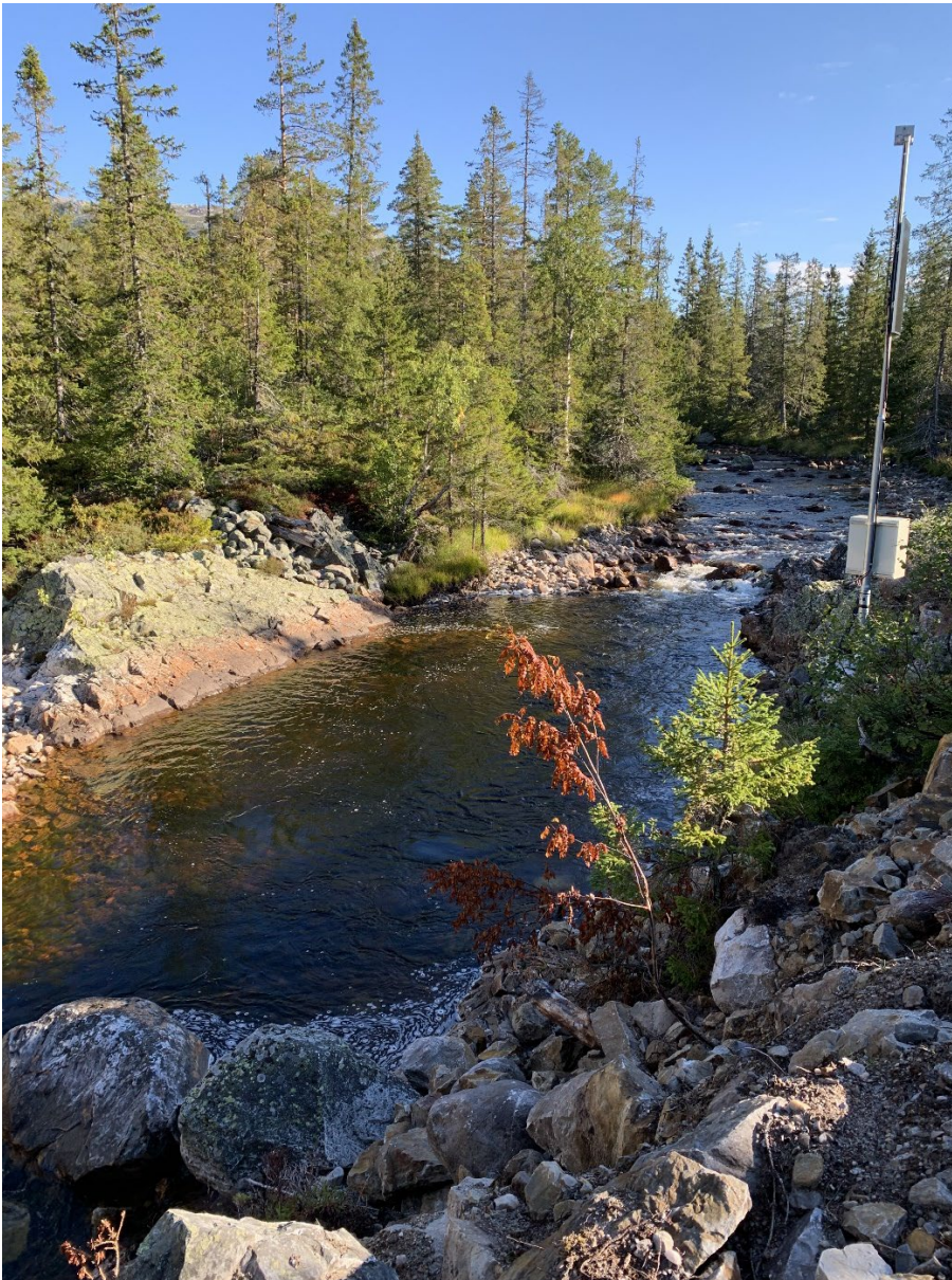
Figur 5-3 Oppstrøms inntaket. Dato: 07.09.2022. 09:42, Q = 0,84 \text{ m}^3/\text{s} .
