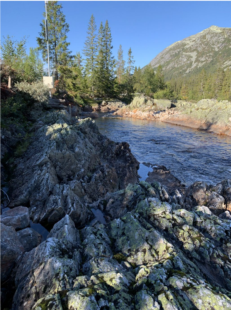
Figur 5-4 Oppstrøms inntaket. Dato: 07.09.2022., 09:42, Q = 0,84 \text{ m}^3/\text{s} .
