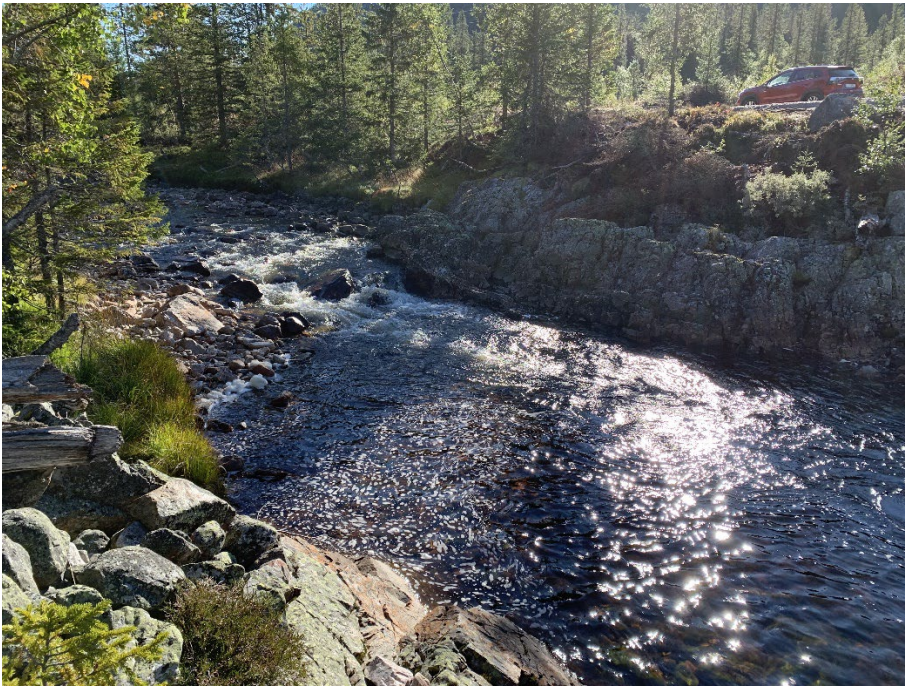
Figur 5-7 Oppstrøms inntaket. Dato: 07.09.2022., 09:54, Q = 0,84 \text{ m}^3/\text{s} .
