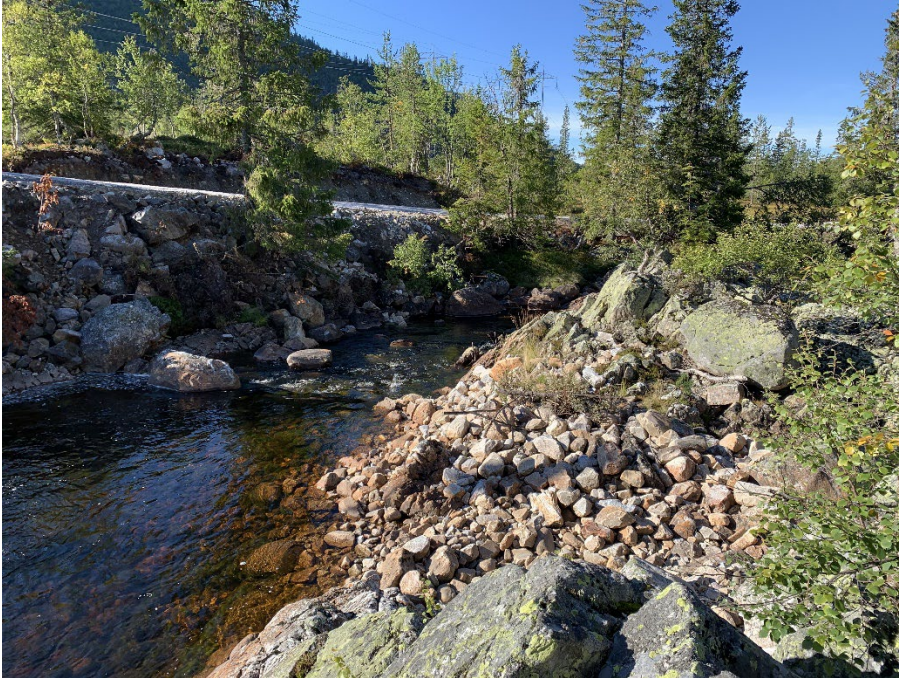
Figur 5-11 Oppstrøms inntaket. Dato: 07.09.2022., 09:54, Q = 0,84 \text{ m}^3/\text{s} .
